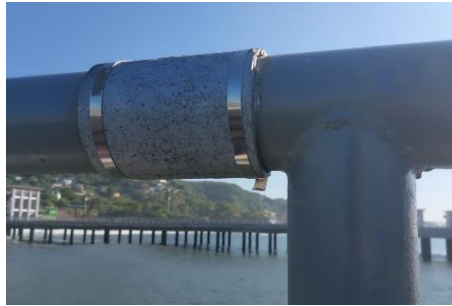
Figura 3.10. Instalación del ánodo de sacrificio en el pasamanos del muelle del Puerto La Libertad.
