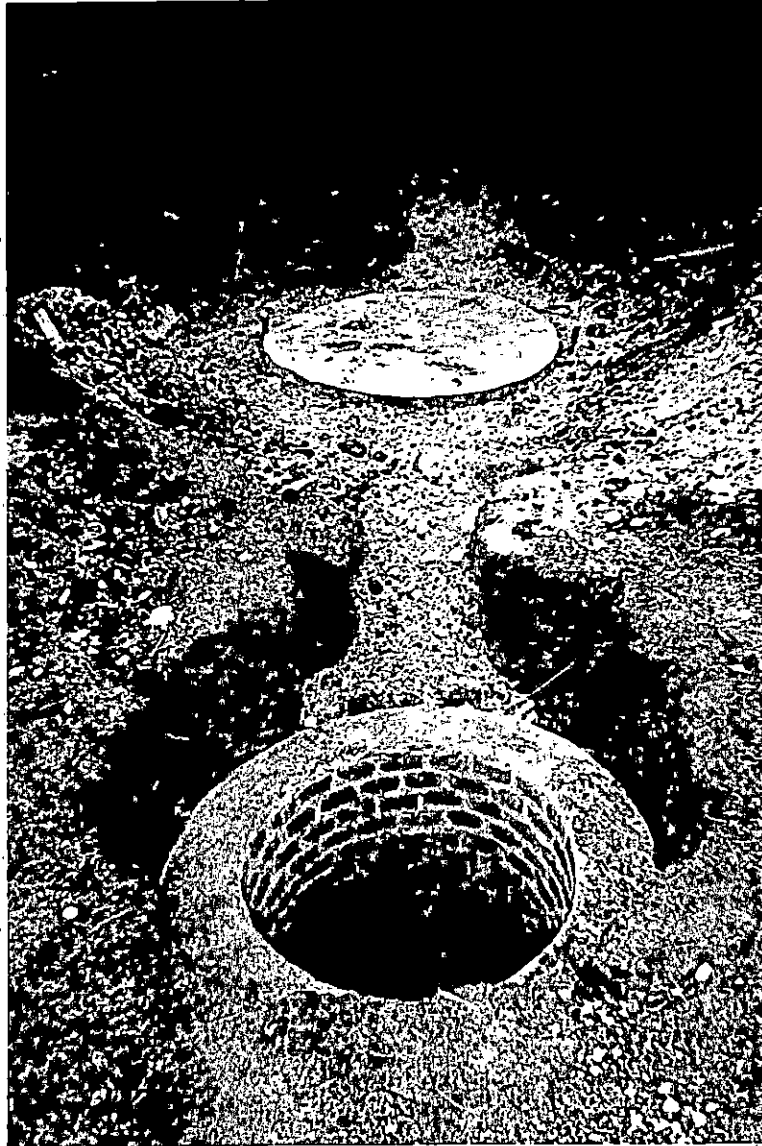
Pozo de absorción, construido a principios de 1997, en la Zona Académica Norte
