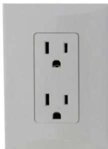
Fotografía 23: Tomacorriente doble polarizado
