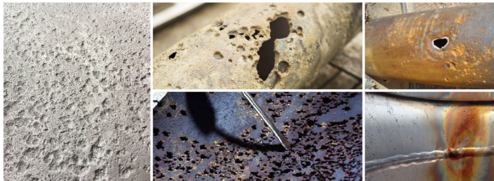
Figura 2.13: Corrosión por picaduras. Fuente: Blog A-Marine (diciembre de 2023)
