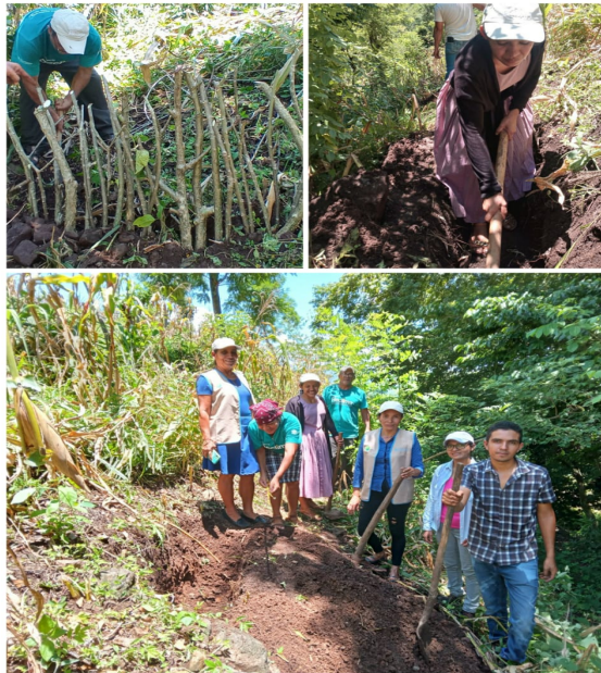
Anexo 40. Elaboración de fosas de infiltración y barreras vivas para protección de fuentes de agua junto con los promotores/as comunitarios.
