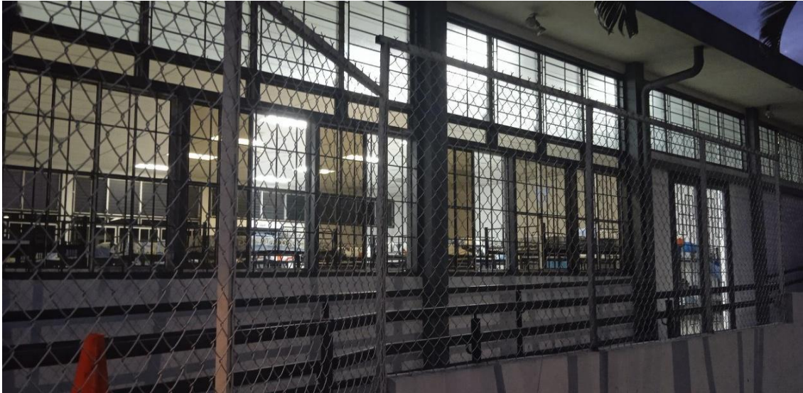
Fuente: Fotografía del exterior del albergue de la colonia Guadalupe, Soyapango. Tomada por estudiantes egresados de la Universidad de El Salvador.
