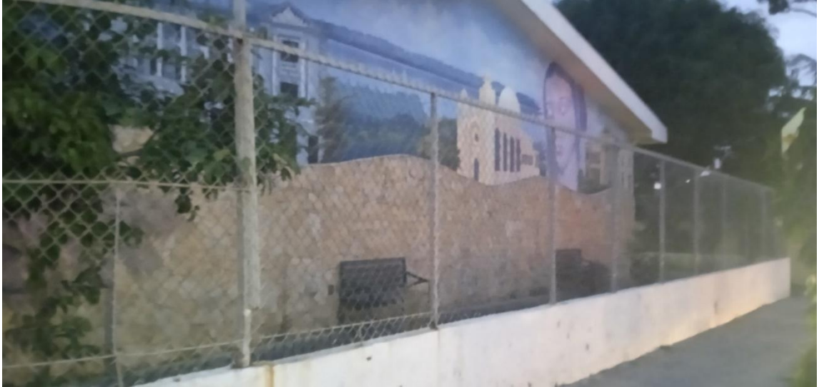
Fuente: Fotografía del exterior del albergue de la colonia Guadalupe, Soyapango. Tomada por estudiantes egresados de la Universidad de El Salvador.
