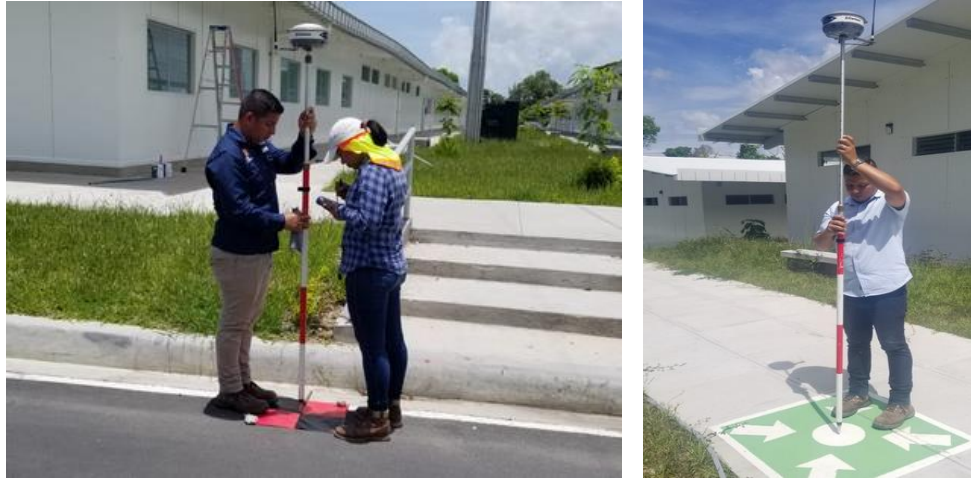
Imagen 4.21: Levantamiento de los PCF en Villa UES.
