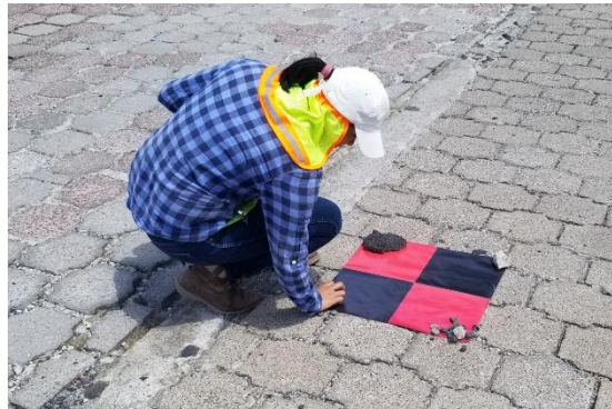
Imagen 4.19: Colocación de marcas PCF.
