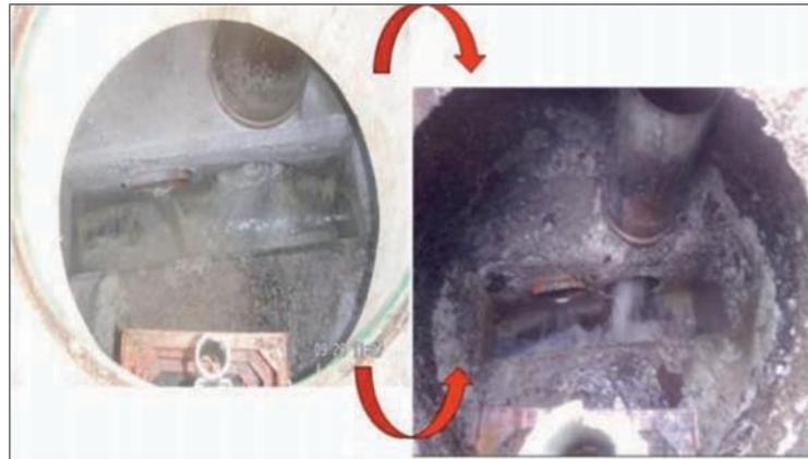
*Ilustración 2.9 Alteración general de la arqueta de recogida de agua depurada en un tanque de oxidación total tras 3 años de servicio. (Han & Klute, 1990)*
