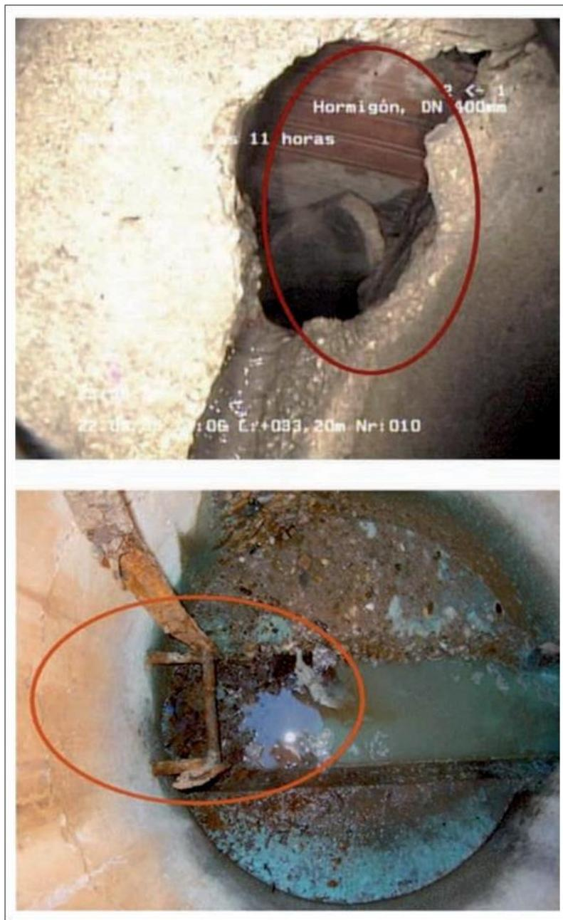
*Ilustración 2.2 Agresión ácida sobre una acometida industrial de aguas residuales a un colector general de saneamiento (superior); (debajo) efectos de un vertido ácido sobre elementos de obra y metálicos en un pozo de registro. (Han & Klute, 1990).*
