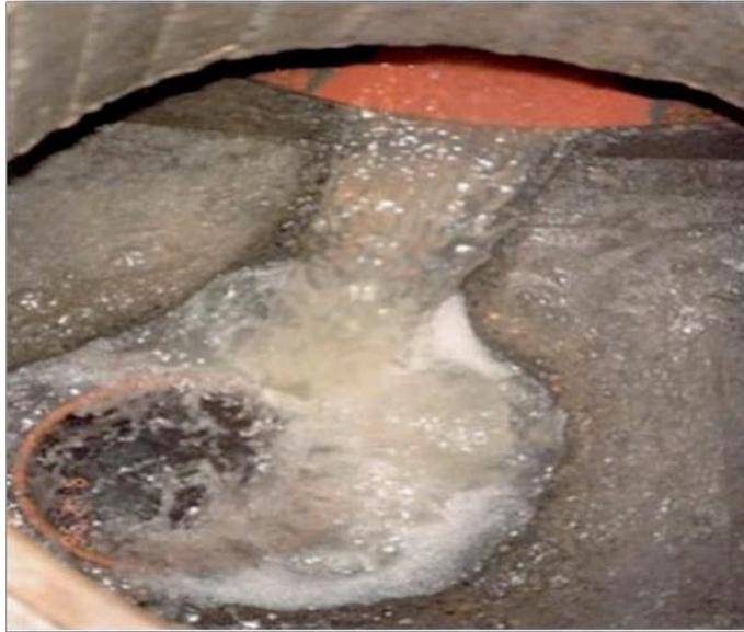
*Ilustración 2.3 Efecto de vertidos alcalinos sobre una acometida de aguas residuales industriales. (Tchobanoglous, 1985)*
