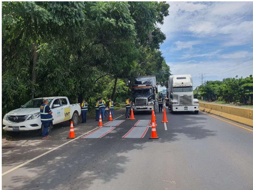
*Imagen 3. 19 Obsérvese las dos bandas en el piso y la unidad de pesaje en el dentro de cada banda. La selección de unidades es al azar.*
