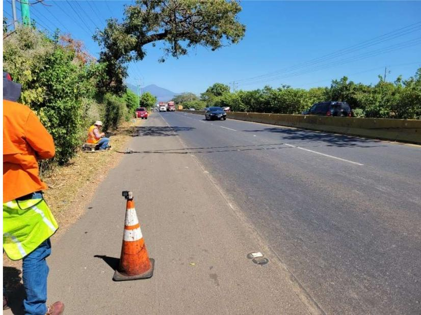
*Imagen 3. 16 Instalación del ROADPOD VT4. Tramo III, Lateral Izquierdo
