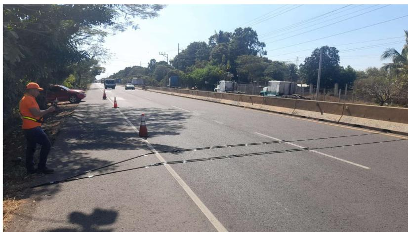
*Imagen 3. 17 Instalación del ROADPOD VT4. Tramo IV, Lateral Izquierdo
