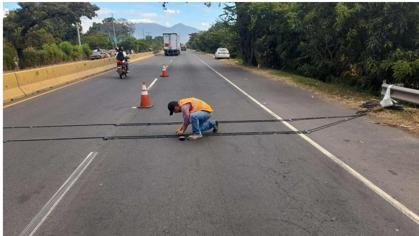
*Imagen 3. 15 Instalación del ROADPOD VT4. Tramo III, Lateral Derecho
