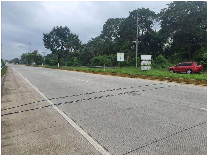
*Imagen 3. 13 Instalación del ROADPOD VT4. Tramo II, Lateral Derecho.
