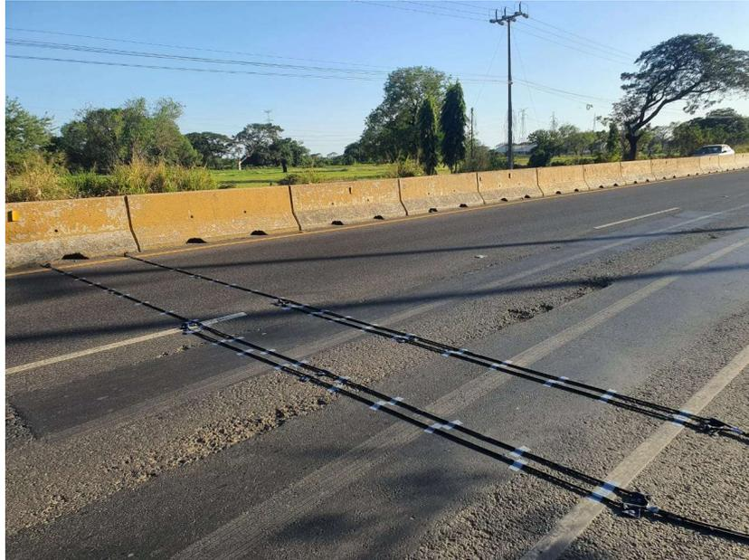
*Imagen 3. 18 Instalación del ROADPOD VT4. Tramo IV, Lateral Derecho
