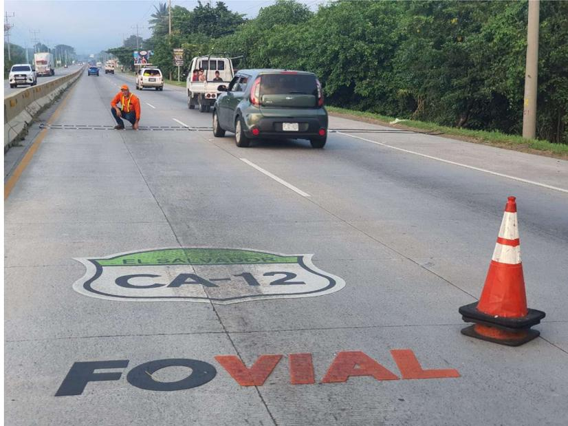
*Imagen 3. 14 Instalación del ROADPOD VT4. Tramo II, Lateral Izquierdo
