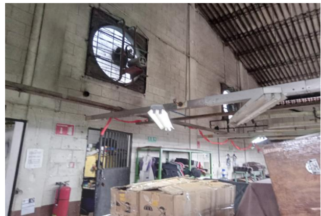
Ilustración 14: Extractores en la planta
