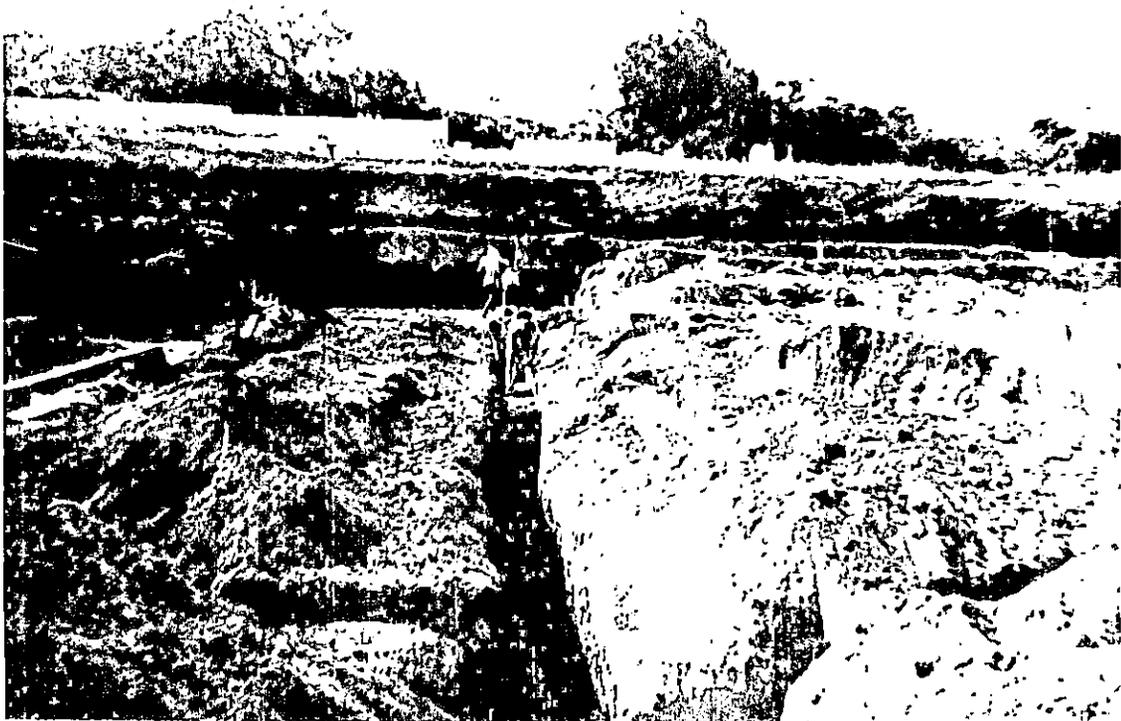
Fotografía 7.11 Vista mostrando excavación de zanja para agua potable.
