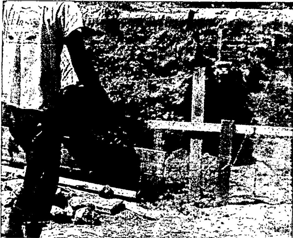
Fotografía 7.23 Se muestra el trazo para la excavación de los cordones y cunetas
