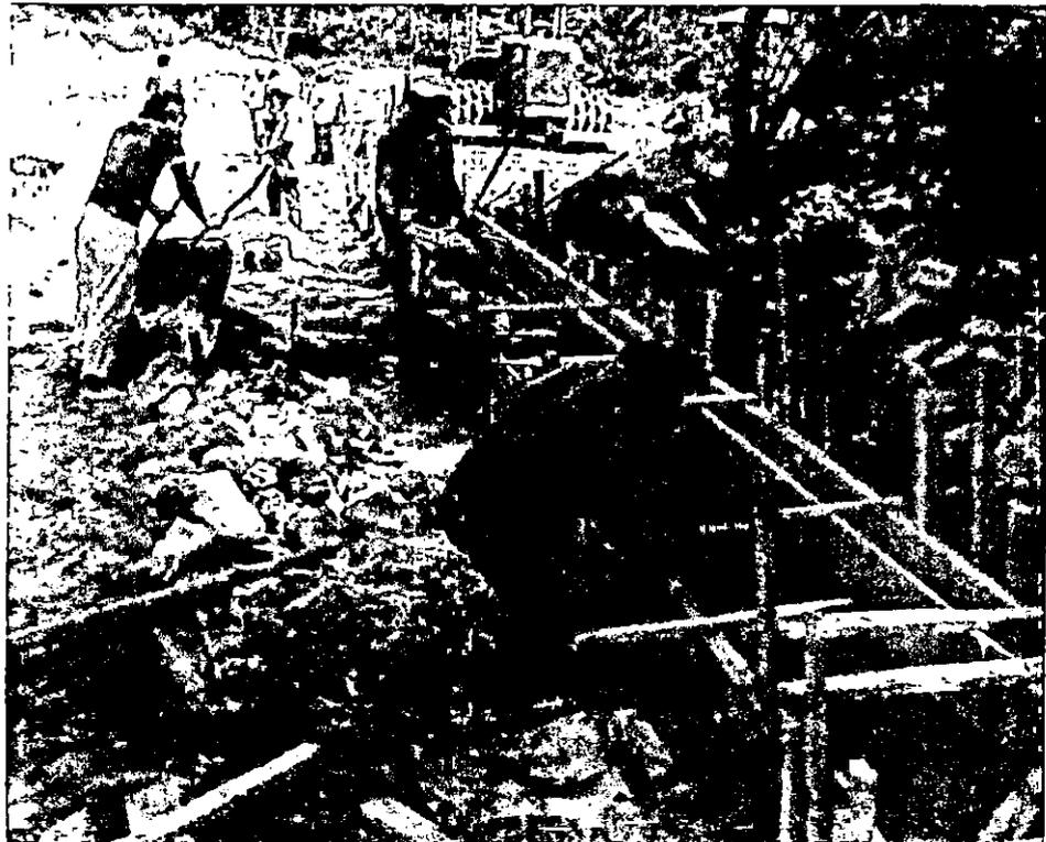
Fotografía 7.24 Mostrando el encofrado mediante moldes de madera para el colado de los cordones y cunetas
