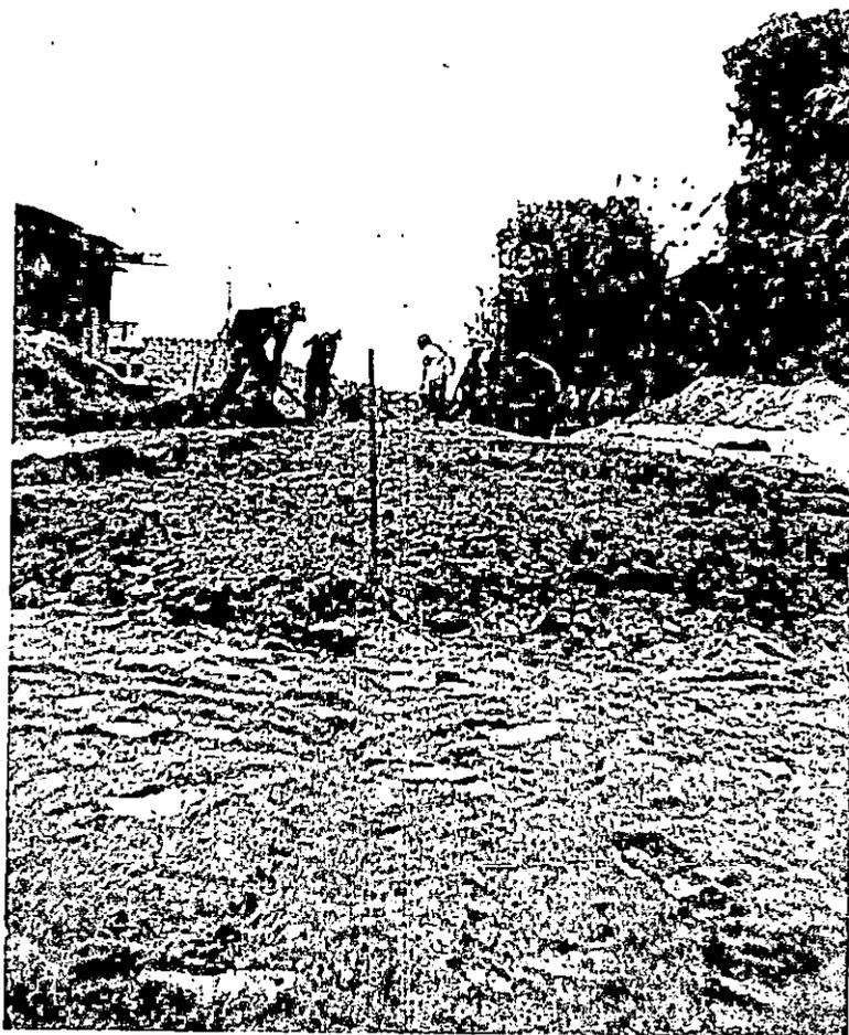
Fotografía 7.25 Ilustración de la nivelación de sub-rasante de la calle principal (Av. "A") de la Urbanización El Manzano III
