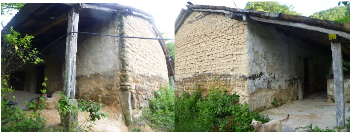
Figura A-3 Estado actual de la infraestructura comunal del Cantón Sumpul Chacones
