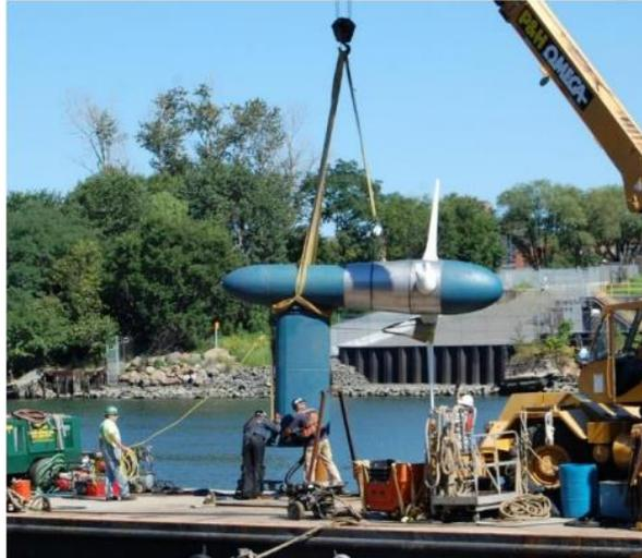
*Ilustración 17 Turbinas de marea (Verdant Power, 2016)*
