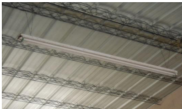
Anexo 9. Lámpara sin protección contra rotura, suciedad e insectos en área de procesamiento de panela granulada.
