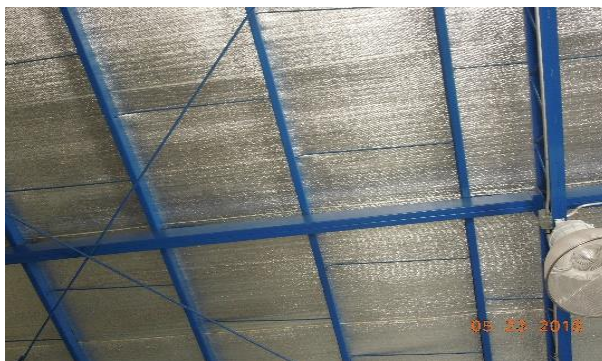
Anexo 8. Techo con aislante térmico para aislar el calor y mantener la temperatura en el área de empaqueo del dulce de panela.
