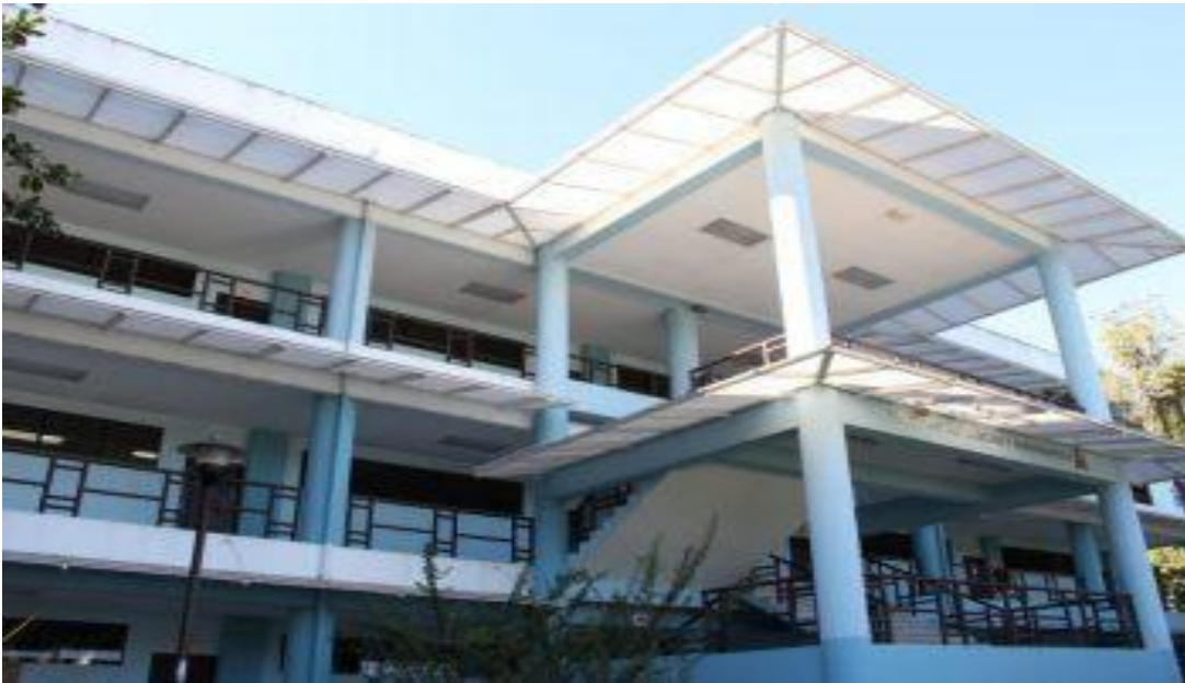
Edificio Dagoberto Marroquín, Facultad de Ciencias y Humanidades, Universidad de El Salvador, Cede Central.
