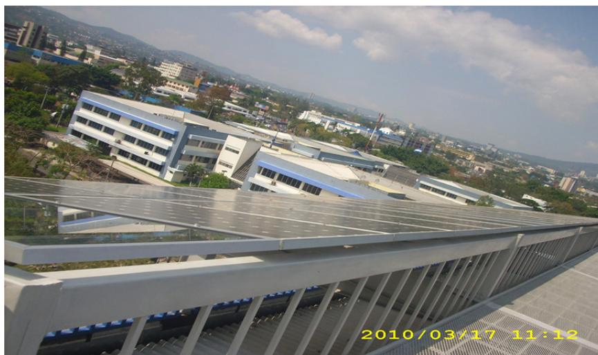
Figura 11. Vista del Generador de Paneles Monocristalinos
