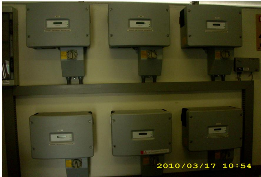
Figura 18. Muestra los 3 inversores para los arreglos monocristalinos arriba y los 3 policristalinos abajo.
