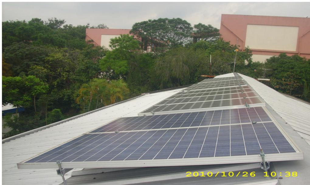
Figura 7.1 Planta fotovoltaica en techo de la Escuela de Ingeniería Eléctrica de la Universidad de El Salvador
