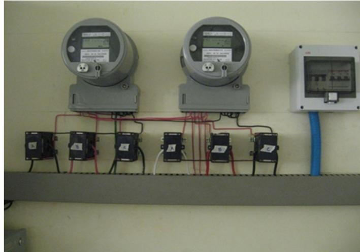
*Figura 7.4 Medición de energía, medidor izquierdo bidireccional registra entrada y salida de energía, medidor derecho registra energía consumida por la carga.*
