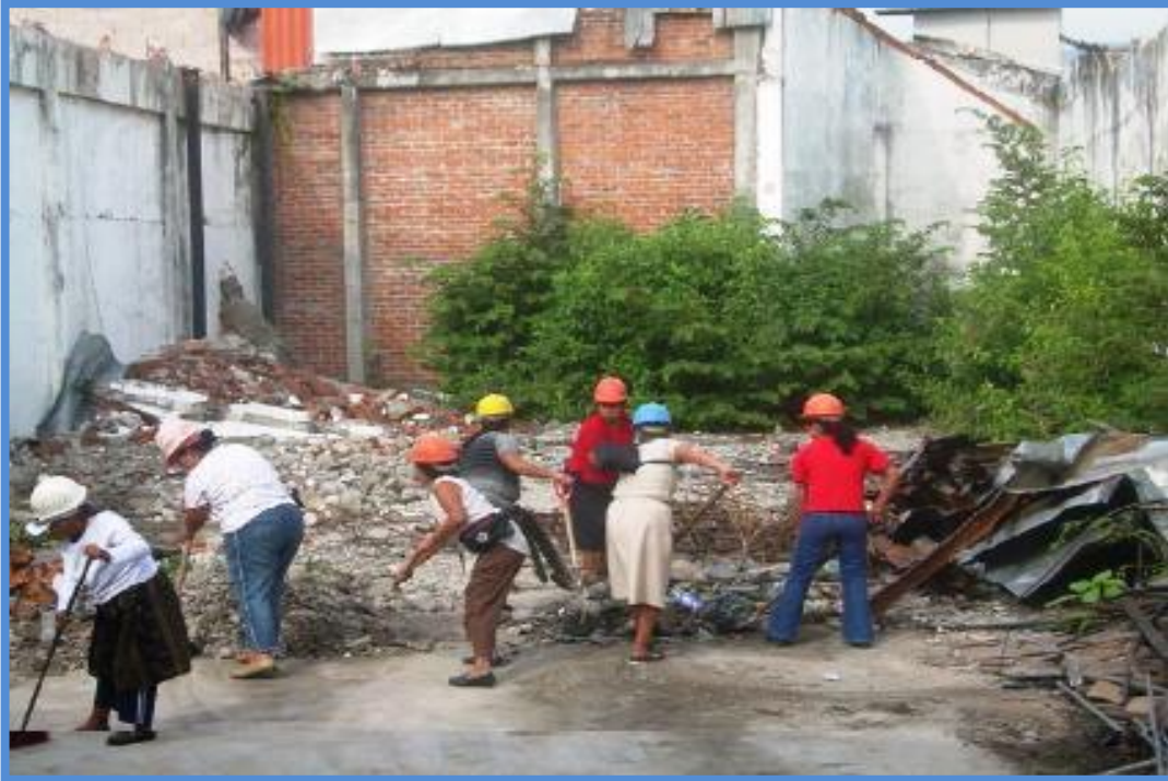
Fotografía tomada a mujeres cooperativistas en la preparación de terracería para la construcción del proyecto habitacional ACOVIVAMSE, proporcionada por secretaria del consejo de administración.
