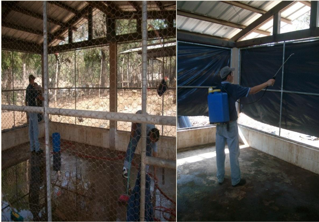
Figura 6. Limpieza de la galera.
