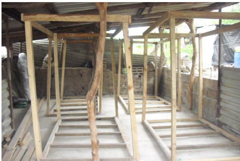
Figura 12: construcción de jaulas.
