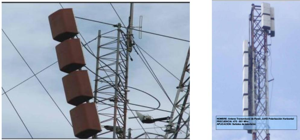
**Figura 1.21: Antenas tipo paneles para transmisión de señales de televisión, estas esta ubicadas en el “Boqueron” volcán de San Salvador [63].**
