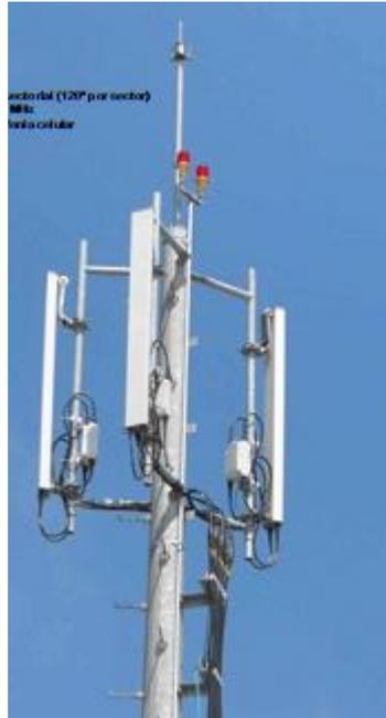
**Figura 1.34: estación base con soporte tubular individual [63].**
