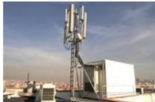
**Figura 1.35: Ejemplos de macro células en azoteas de edificios y torres [63].**
