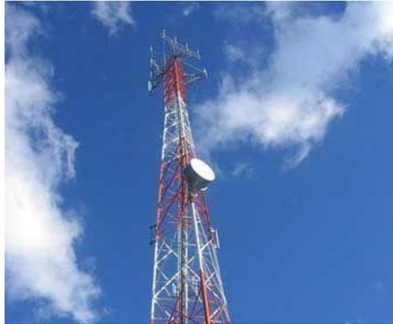
**Figura 1.32:** Torre auto soportada de sección transversal triangular de una estación base celular que puede estar en zona urbana o rural [63].
