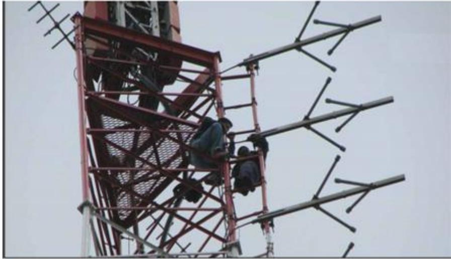
**Figura 1.11: Arreglo de antenas típico de las estaciones de radio FM ubicadas en nuestro país [63].**
