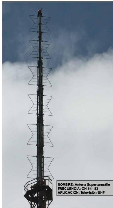
**Figura 1.22: Arreglo de antenas de UHF de sistemas de transmisión de televisión.**
