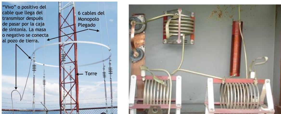
**Figura 1.15: Antena vertical, torre y caja de acople (sintonía) típicos de una estación de radio AM.**
