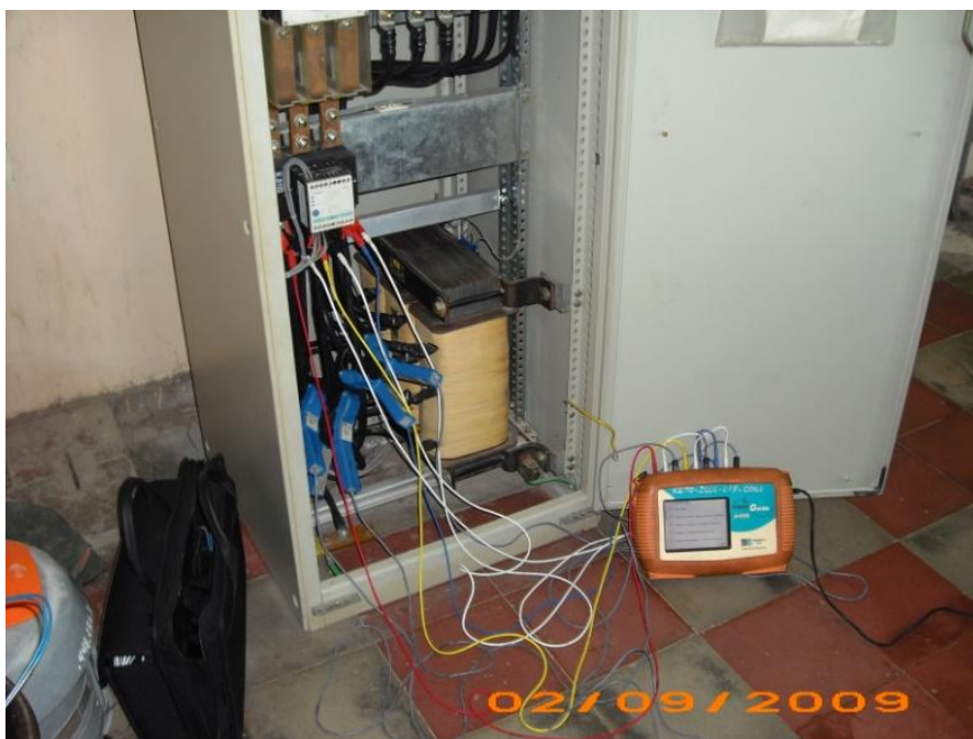
FOTOGRAFÍA QUE MUESTRA EL EQUIPO DRANETZ 4400 MIDIENDO EN UN TABLERO DE CONTROL DE UNA BOMBA DE AGUA.
