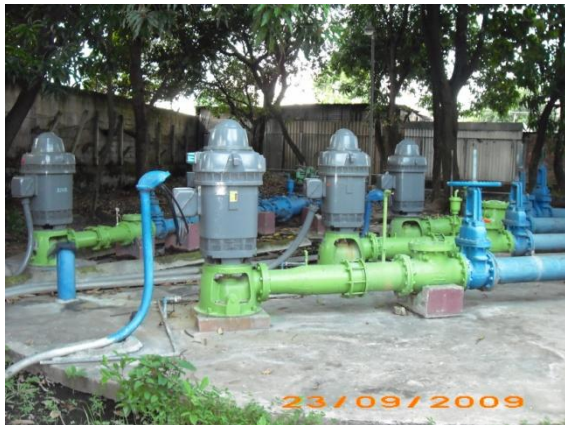
FOTOGRAFÍAS QUE MUESTRAN A LA IZQ. UNA ESTACION DE BOMBAS EN PARALELO. A LA DER. LOS TABLEROS DE CONTROL PARA CADA BOMBA.
