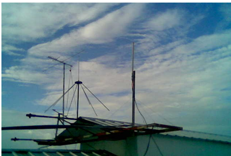
Figura 1: Instalación de la antena omnidireccional
