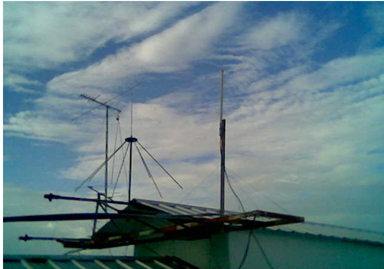
Figura 4.7: Instalación de la antena omnidireccional
