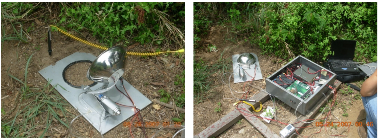
Figura 4.8 Montaje de sensores y estación multiparametrica.
