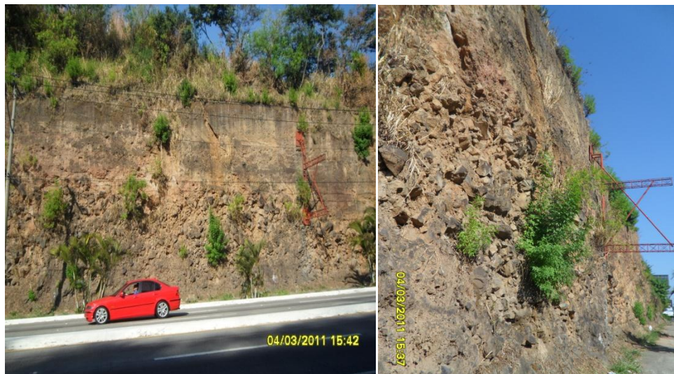
Figura 2.7 Talud aparentemente estable en tramo entre el monumento al hermano lejano y rancho Navarra, donde comienza la antigua calle a Huizucar, sobre autopista a Comalapa.
