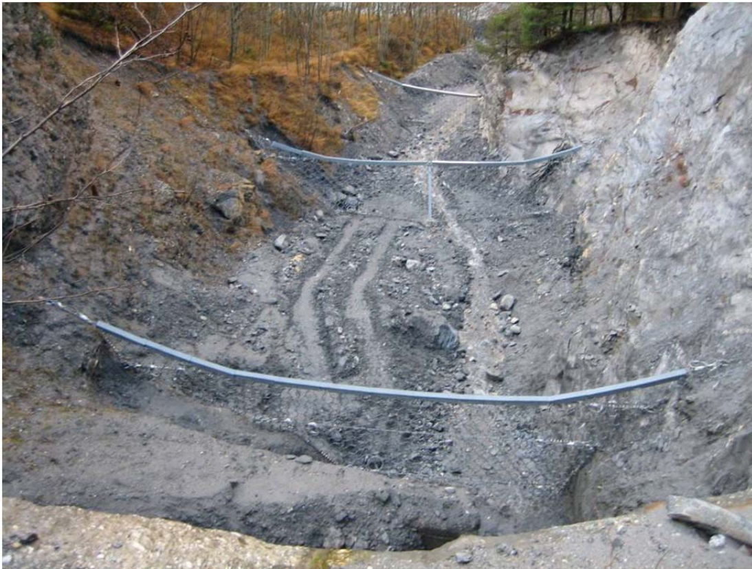
Merdenson / Suiza (2006): 3 barreras con concepto "multi-nivel", vista hacía aguas abajo
