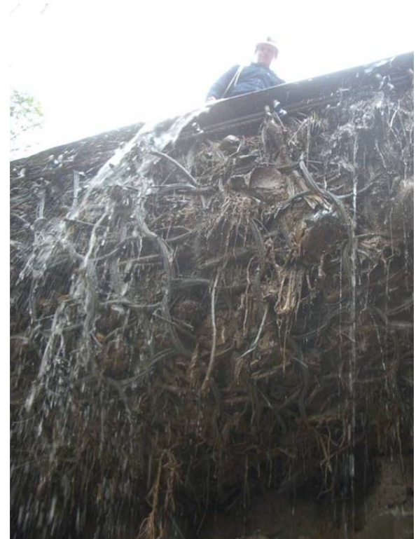
Vista hacia aguas arriba a ambos extremos (izquierdo y derecho) y de la parte frontal de la misma barrera UX, que fue expuesta a entre 8 a 10 impactos de huaycos con un volumen total de aprox. 90'000 m 3 y esto dentro de un periodo de aprox. 2 meses. Dicha barrera mostró así su alto grado de desempeño.
