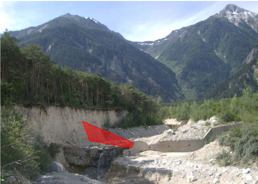
Illgraben, Schwelle 25 / Suiza (2007): Otro ejemplo para sustitución exitosa de una estructura de concreto como primer paso para poder corregir la dirección del caudal hacía la derecha y proteger la ladera izquierda de erosión. Con esta finalidad se planifica una segunda barrera (con forma triangular), colocada de manera sesgada y arriba de la primera barrera.
