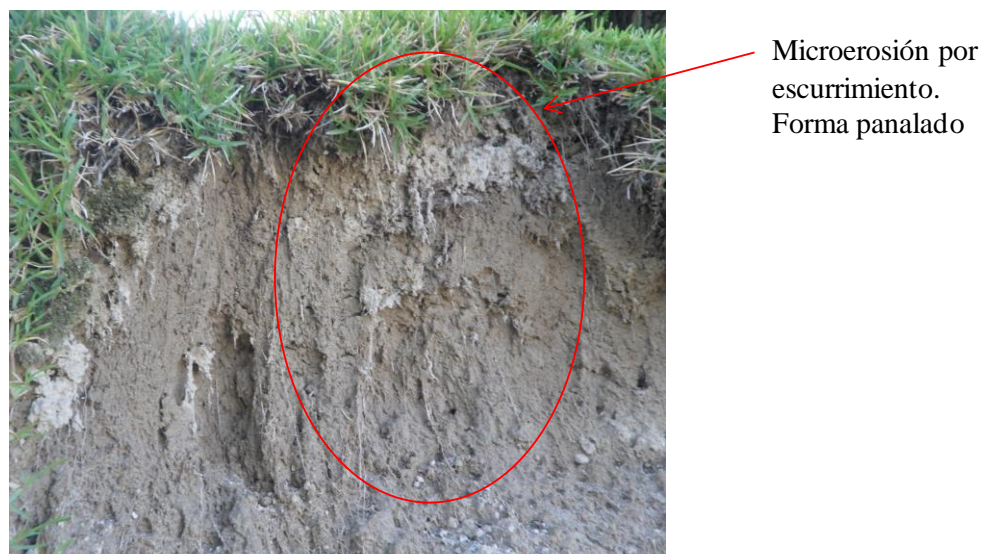
Figura 6. Parte superior del deslizamiento de tierra. Se observó microerosión, como panalado.
