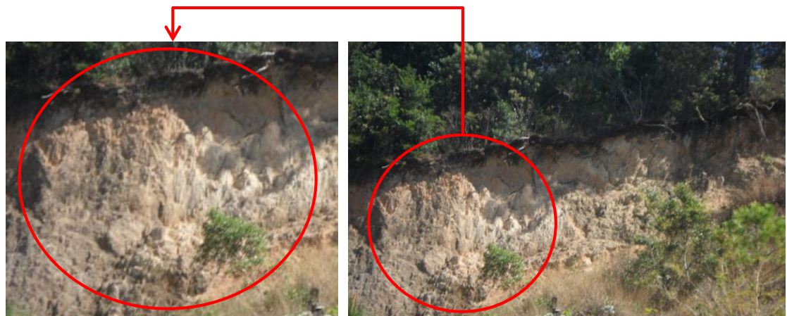
Figura 7. Corona de la cárcava. Se observa coloración parda oscura debido a la meteorización generalizada, oxidación y degradación del estrato superior, sub-yacente al estrato de orgánico. Hay vegetación superficial, tipo maleza, reptación lenta en tobas, perceptible en los arbustos.
