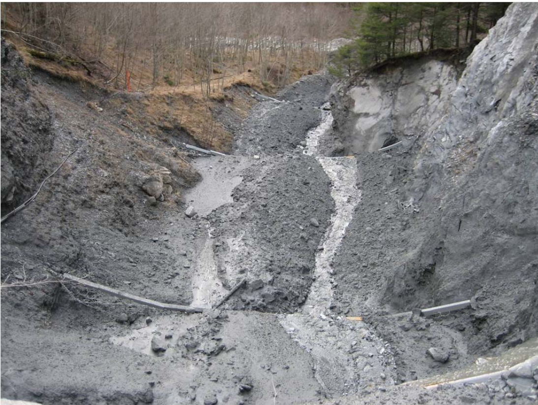
Merdenson / Suiza (2007): 3 barreras (2 x tipo UX, 1 x tipo VX) con concepto "multi-nivel" después de impactos por 2 flujos de detritus en enero y marzo 2007, vista hacía aguas abajo
