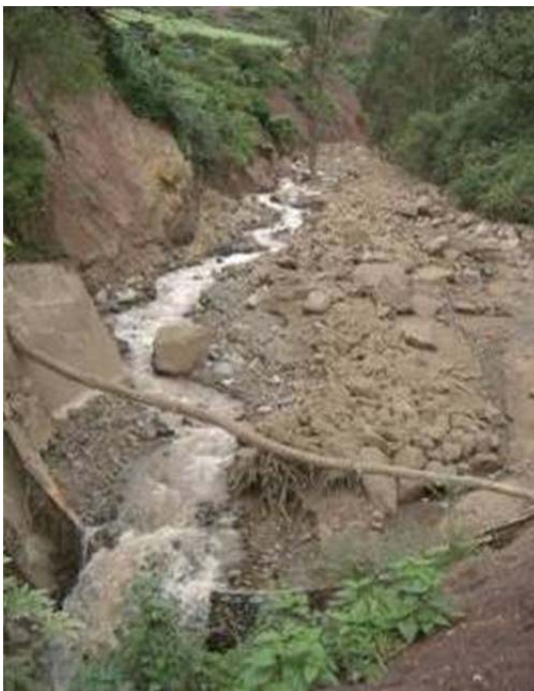
Vista hacia aguas arriba: Aparte del material exitosamente retenido de aprox. 15'000 a 18'000 m 3 de flujo de detritos (huayco), incluso bloques largos arrastrados, aprox. 75'000 a 72'000 m 3 desbordaron la barrera llena dentro de un periodo de aprox. 2 meses entre febrero y marzo 2009.
