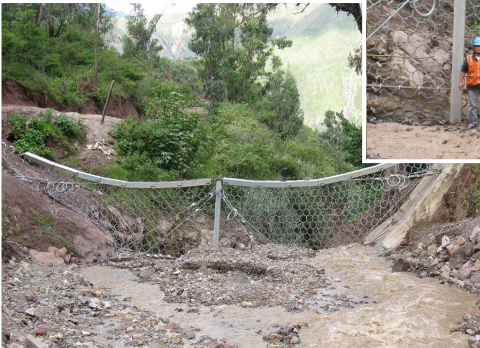
Misma barrera UX llenada hasta su mitad aproximadamente
