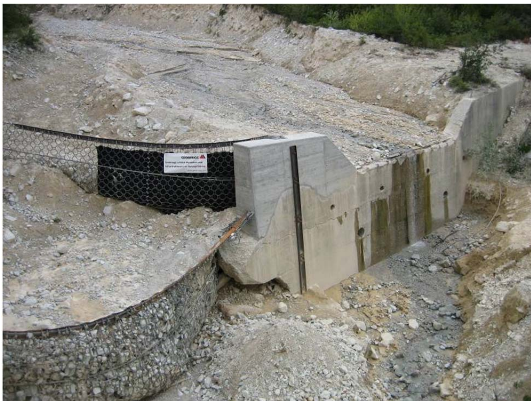
Illgraben, Schwelle 25 / Suiza (2008): Instalación completamente terminada (2 da barrera con longitud de 12 m y altura de 4 m) para poder corregir la dirección del cauce y evitar así erosión en la ladera)
