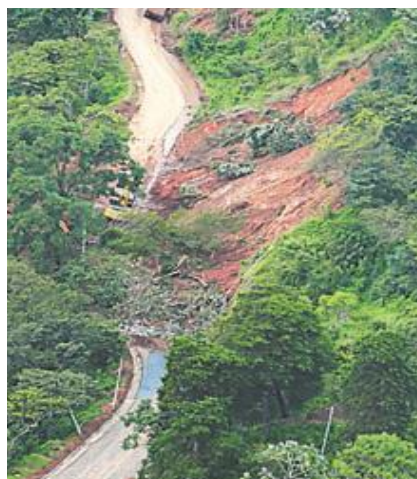
Figura 17 Derrumbe ocurrido sobre la calle que conduce al Bajo Lempa. Jueves 20 de octubre de 2011.
