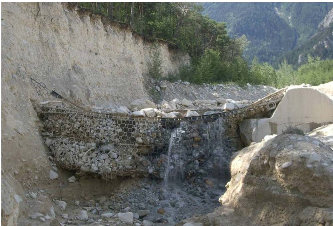
Illgraben, Schwelle 25 / Suiza (2007): Vista de la barrera ya instalada y después de 2 impactos diferentes
