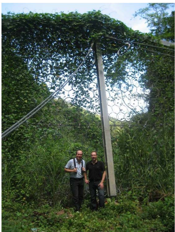
Osorio / Venezuela (2008): 2 barreras tipo UX/VX instaladas en concepto multi-nivel
