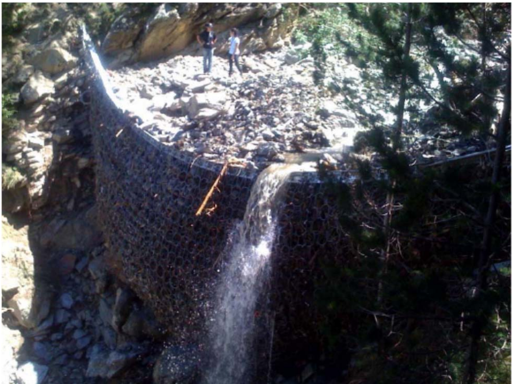
Erill y Port-Ainé, Cataluña / España (2010): Con las precipitaciones del pasado 22 de Julio, la barrera de Erill retuvo 1.400 m 3 de detritos, mientras que las barreras multinivel de Port-Ainé contuvieron en conjunto más de 20.000 m 3 de detritos (marca mundial en su tipo).
