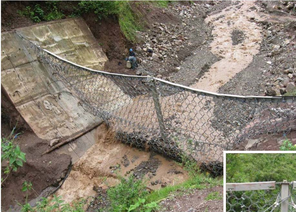
Barrera UX de altura de 5 m vacía
