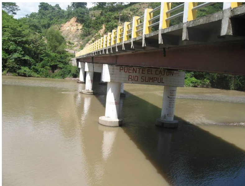
Fotografía 2: Estructura inferior del puente sobre actual sobre río Sumpul
