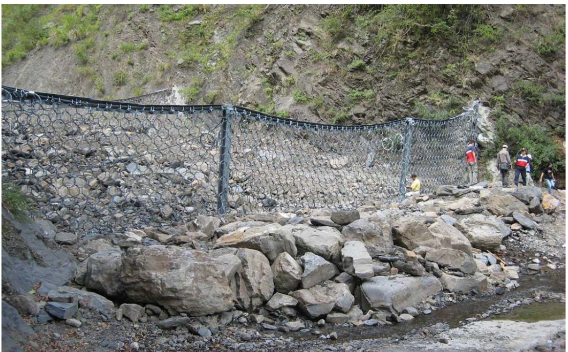
Colocación de bloques lado aguas abajo contra socavación por desborde.
