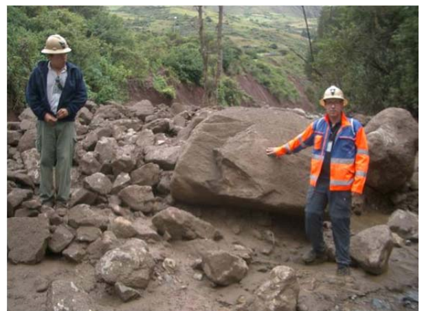
Vista hacia aguas arriba: Aparte del material exitosamente retenido de aprox. 15'000 a 18'000 m 3 de flujo de detritos (huayco), incluso bloques largos arrastrados, aprox. 75'000 a 72'000 m 3 desbordaron la barrera llena dentro de un periodo de aprox. 2 meses entre febrero y marzo 2009.
