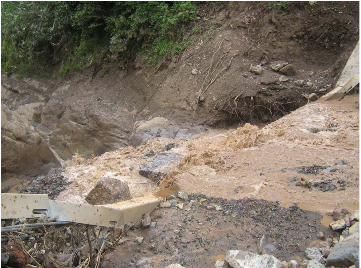
Misma barrera UX totalmente llena hasta cables de soporte superiores
