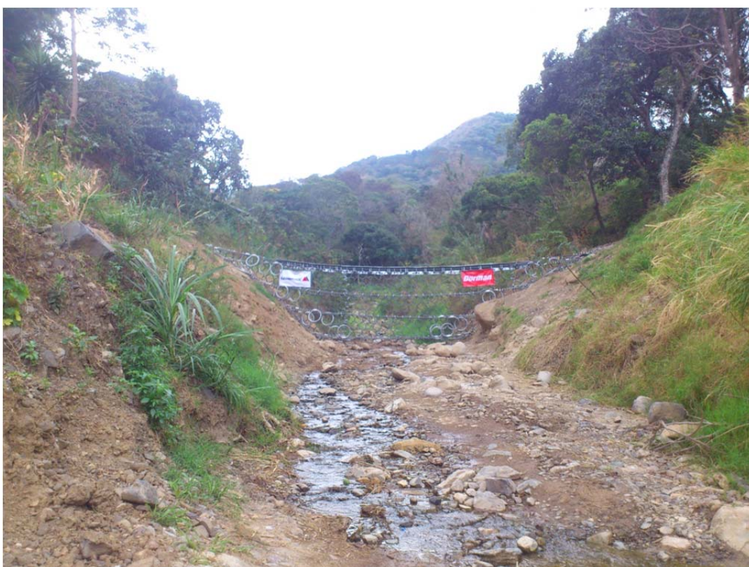
Quebrada Canoas, Costa Rica, barrera VX160-H6
