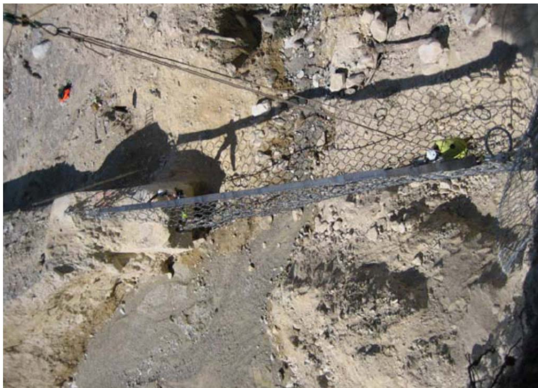
Illgraben, Schwelle 25 / Suiza (2006): Instalación, vista en planta
