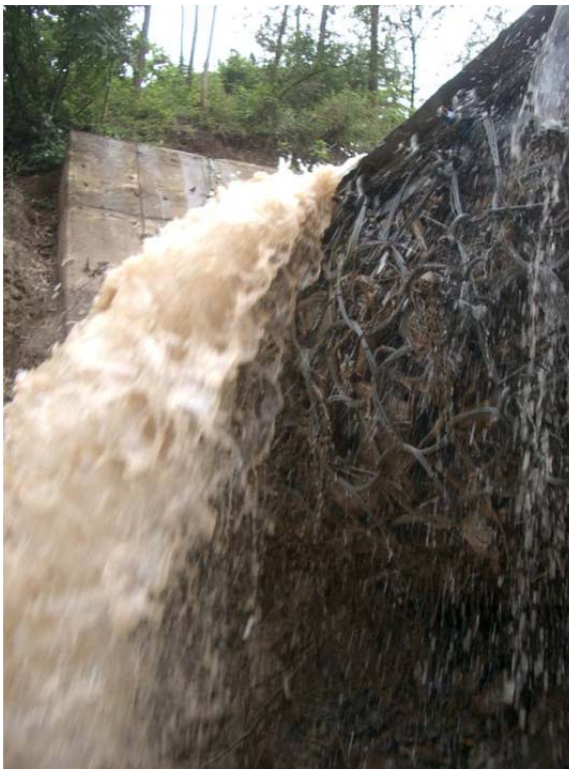
Vista hacia aguas arriba a ambos extremos (izquierdo y derecho) y de la parte frontal de la misma barrera UX, que fue expuesta a entre 8 a 10 impactos de huaycos con un volumen total de aprox. 90'000 m 3 y esto dentro de un periodo de aprox. 2 meses. Dicha barrera mostró así su alto grado de desempeño.
