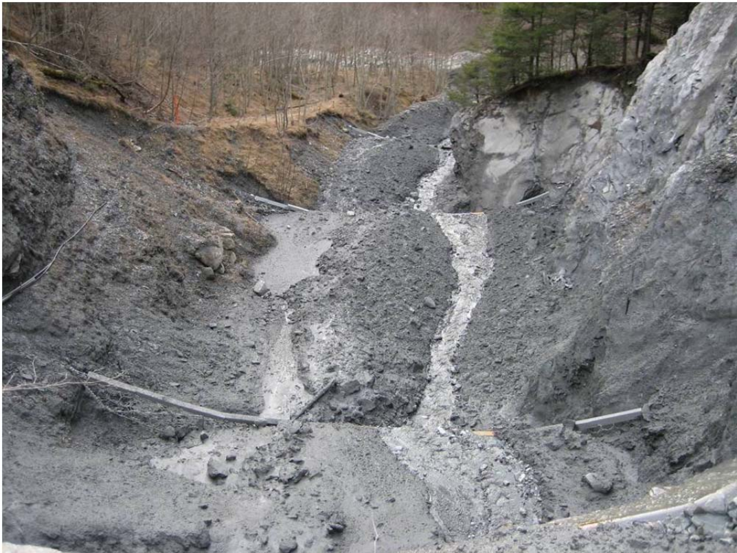
Merdenson / Suiza (2007): 3 barreras (2 x tipo UX, 1 x tipo VX) con concepto "multi-nivel" después de impactos por 2 flujos de detritus en enero y marzo 2007, vista hacía aguas abajo
