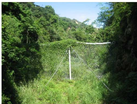
Osorio / Venezuela (2008): 2 barreras tipo UX/VX instaladas en concepto multi-nivel
