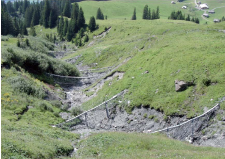
Milibach, Halisberg / Suiza (2008): barreras multinivel, 13 barreras diseñadas para contener más de 10.000 m 3 de detritos..
