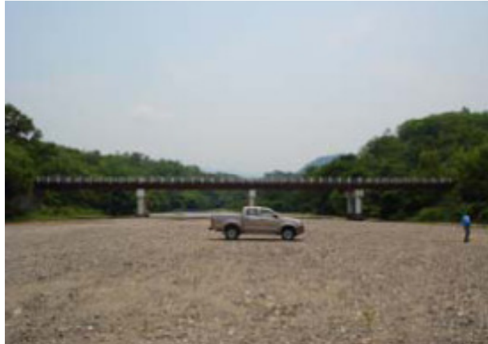
Fotografía 1: Sección del puente actual sobre río Sumpul
