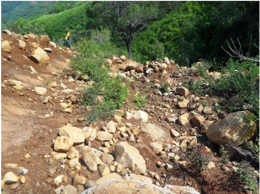
Cuerpo del Deslizamiento
