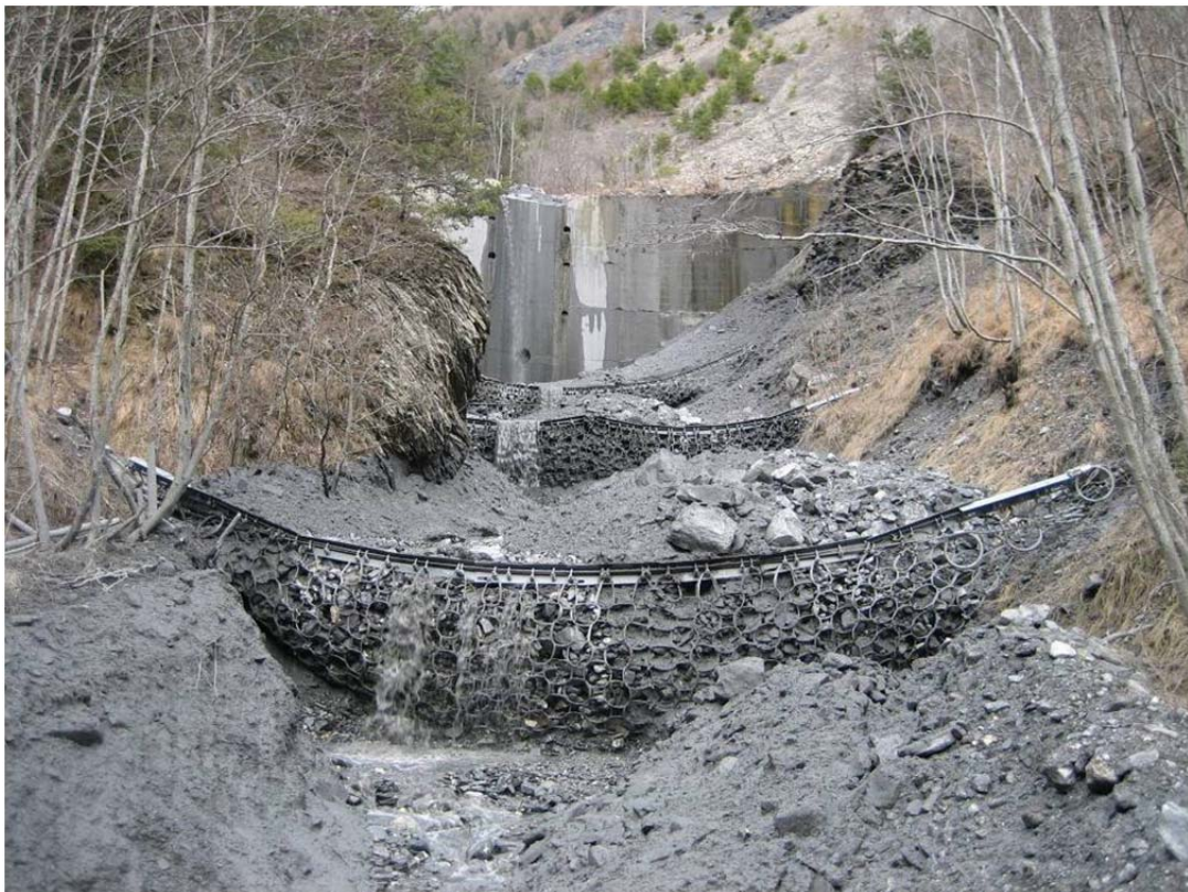
Merdenson / Suiza (2007): Ejemplo exitosa para la protección de un puente aprox. 400 m más abajo en la cuenca y de la sustitución económica de estructuras de concreto ("checkdams"), vista hacía aguas arriba
