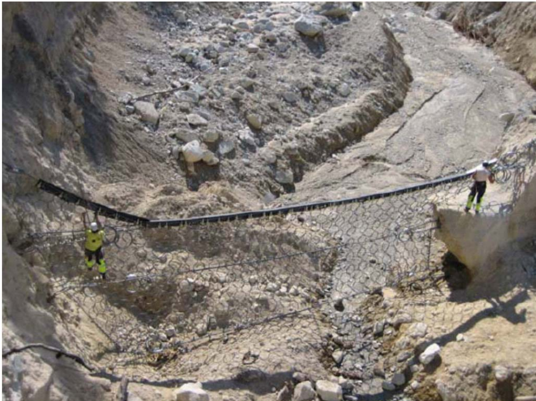
Illgraben, Schwelle 25 / Suiza (2006): Instalación, vista de frente, con 3 días de trabajo para perforación y colocación de los anclajes y 3 días (con 4 personas) para la instalación de la barrera.
