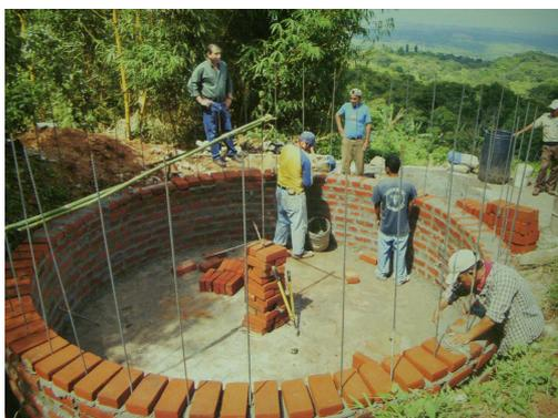
Foto 15. Construcción de tanque de captación de agua, Ahuachapán.
