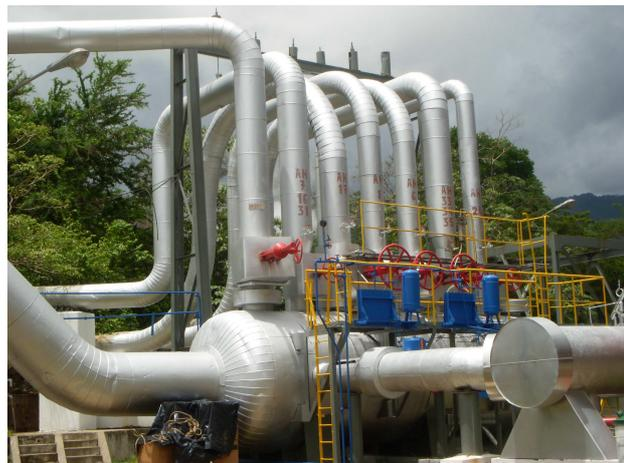
Foto 29. Sistema de colectores de vapor
