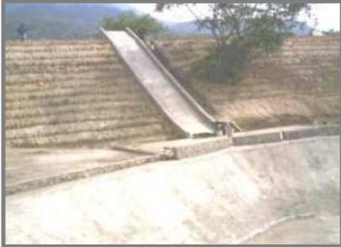
Foto 7. Canaleta para desagüe durante la perforación de pozos
