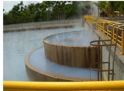
Foto 32. Pozo de condensados
