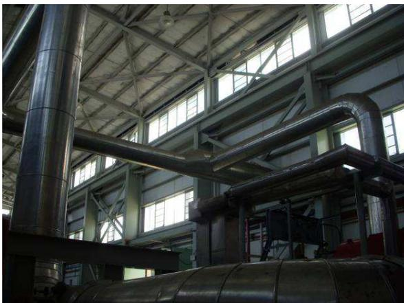
Foto 98. Vista de la estructura metálica y arriostrado de los marcos.
