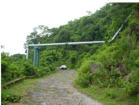
Foto 36. Tubería de acarreo que baja de los pozos productores en la parte alta, debido a la topografía se hace necesario obras de mitigación que eviten derrumbes y daños a la estructura. Para conducir estas tuberías por sobre las montañas se necesitan estructuras de soporte que pasan sobre las calles y caminos vecinales.
