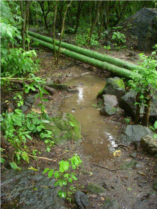
Foto 78. Tuberías atraviesan los senderos generando obstáculos, además se tiene problemas de estancamiento de agua lluvia.
