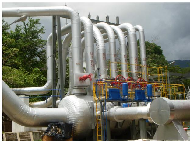
Foto 29. Sistema de colectores de vapor
