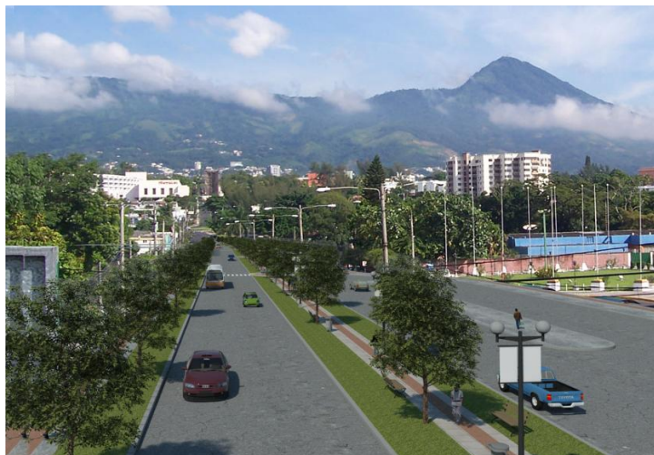
Vista del arriate central, donde se aprecian los elementos de accesibilidad, colocados para facilitar la movilidad para todo tipo de personas, así como la acera colocada al centro del arriate.
