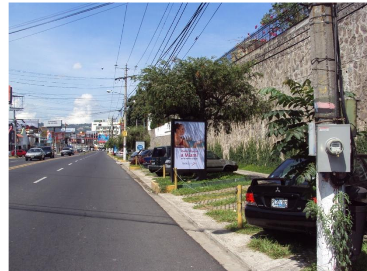
Fotografía 47. Boulevard del Hipódromo, arriates utilizados de estacionamiento.
