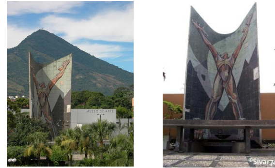
Fotografía 10. Vista general del Monumento a la Revolución.
