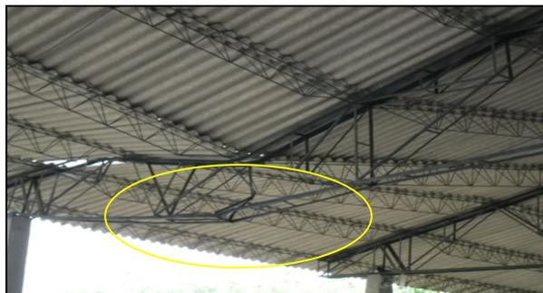
**Fig. 1.20. Pandeo en elemento a compresión en armadura de techo ocasionada por presión de viento.**
