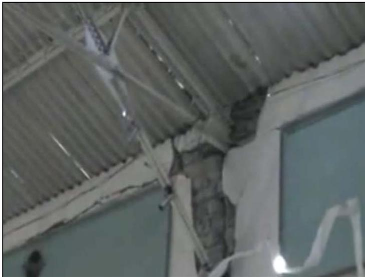
**Fig. 1.21. Falla de agrietamiento en apoyo de techo por carga sísmica.**
