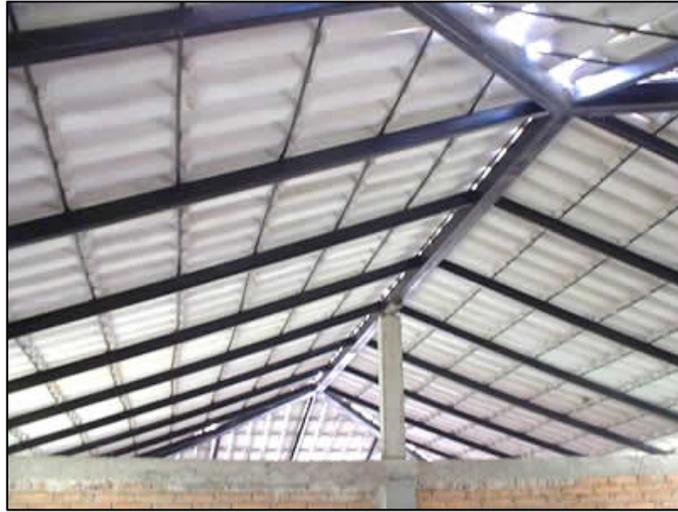
**Fig. 1.7. Estructura de techo conformada por perfiles laminados tipo “C”**
