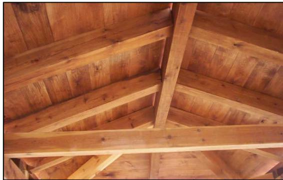
**Fig. 1.6. Estructura de techo de madera**
