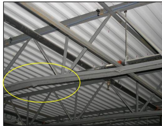
**Fig. 1.18. Pandeo local en viga de alma abierta**
