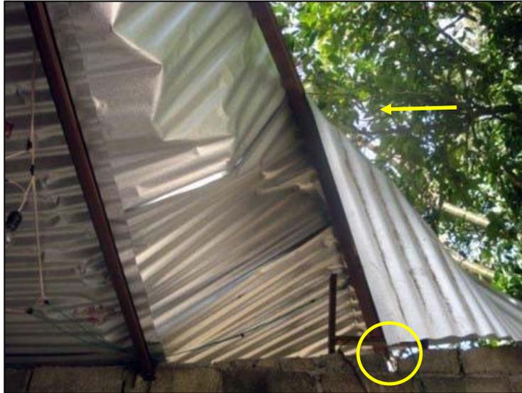
**Fig.1.17. Daños por carga de viento.**
