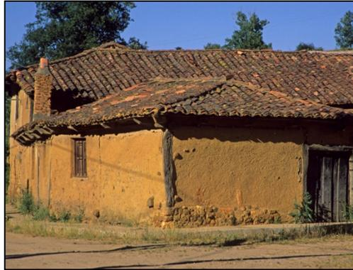
**Fig. 1.2. Cubierta de teja de barro**
