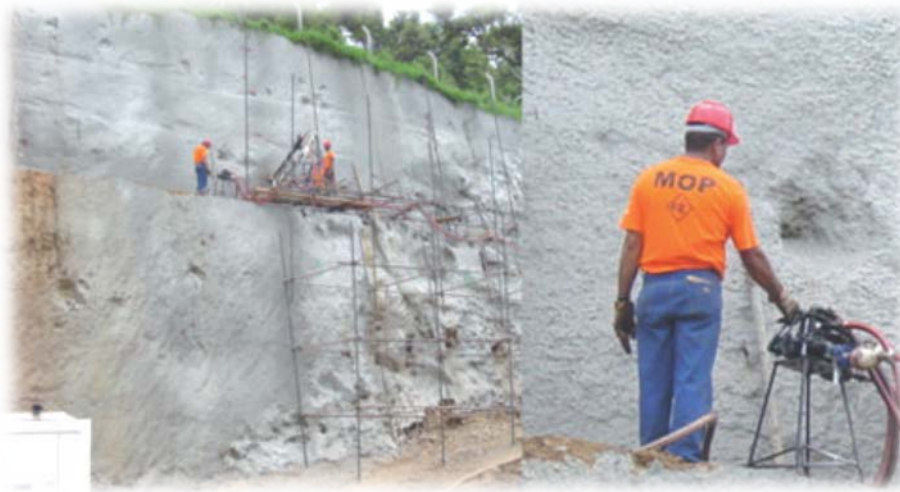
FOTOGRAFÍA N°2.5: Talud revestido con Concreto Lanzado para evitar la erosión.
