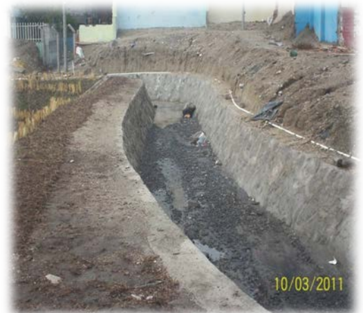
Canaleta de mampostería en la corona de la Cárcava
