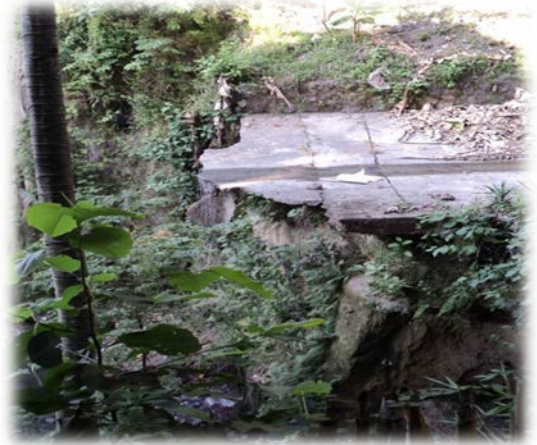
Socavación por caída de agua
