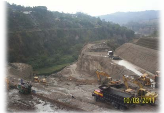
Maquinaria pesada utilizada para la terracería
