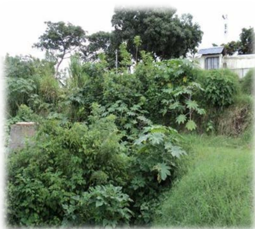
Vista de la corona de la Cárcava
