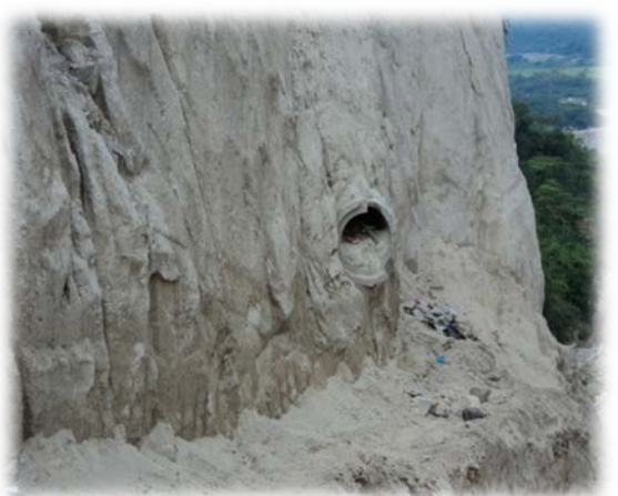
Tubería colapsada
