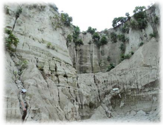
Taludes de tierra blanca altamente erosionados
