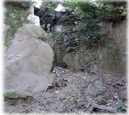
Taludes de la Cárcava
