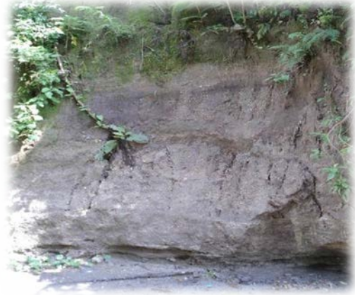
Vista de la erosión lateral en el cauce
