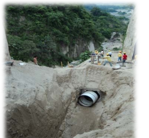
Obras provisionales durante la construcción de las obras
