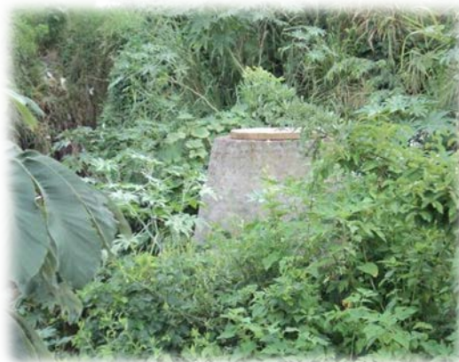
Pozo de aguas lluvias construido recientemente
