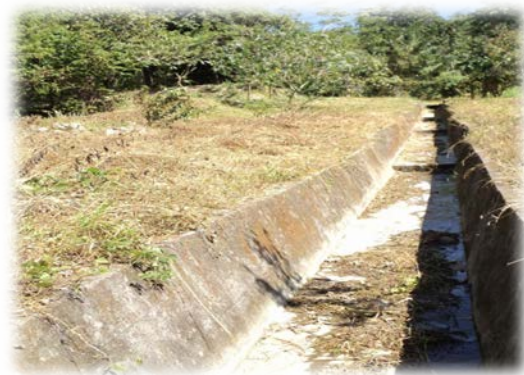
Canaleta de descarga de Aguas Negras y Lluvias, ubicada en la corona de la Cárcava
