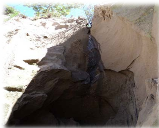
Descarga de Aguas Negras
