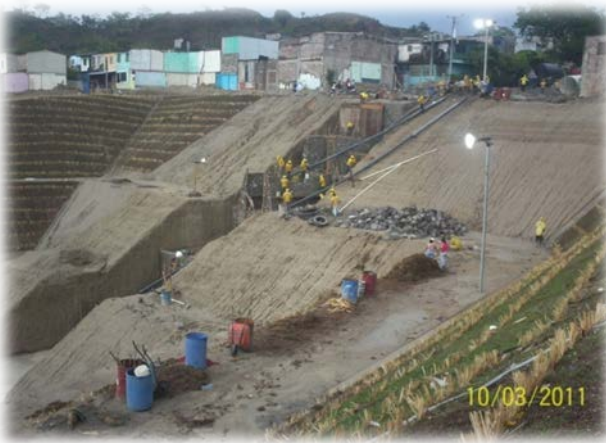
Conformación de bermas y taludes
