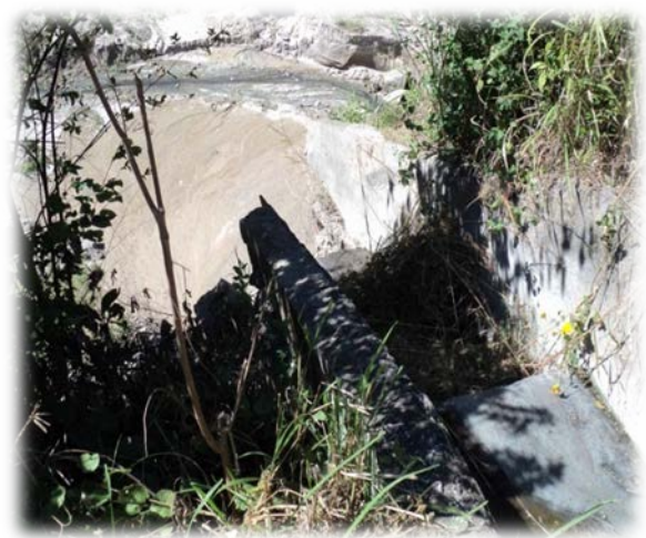
Descarga de aguas negras y lluvias Canaleta
