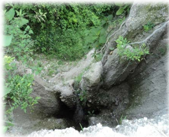
Socavación en los laterales de la Cárcava
