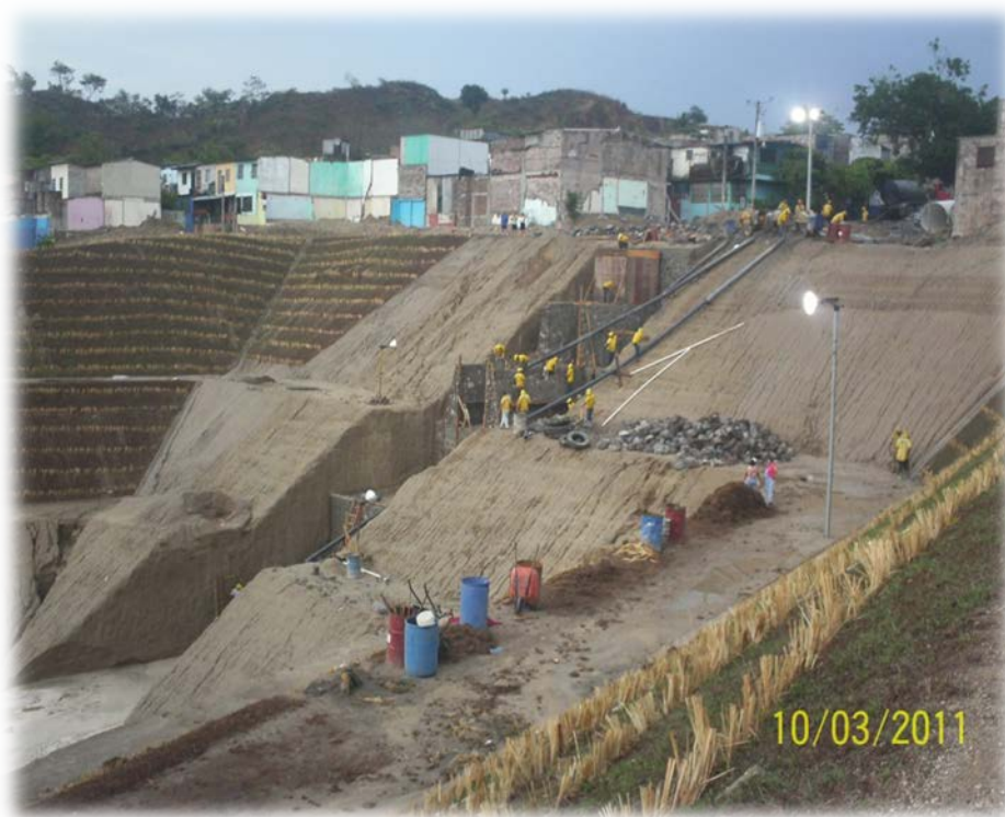
FOTOGRAFÍA N° 2.1: Conformación de Taludes y Bermas en Cárcava Las Cañas, Ilopango, 2011.
