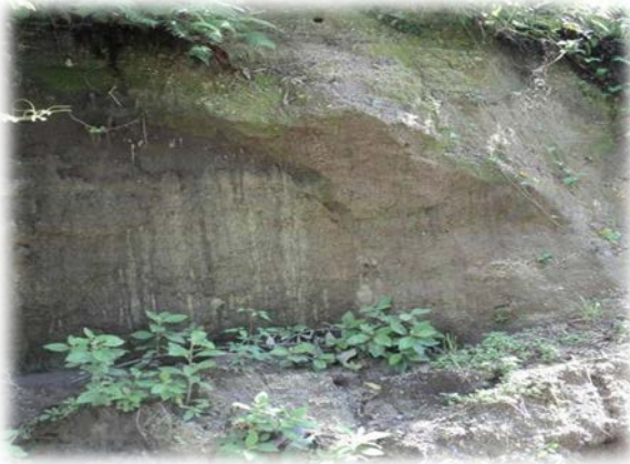
Erosión lateral en el cauce
