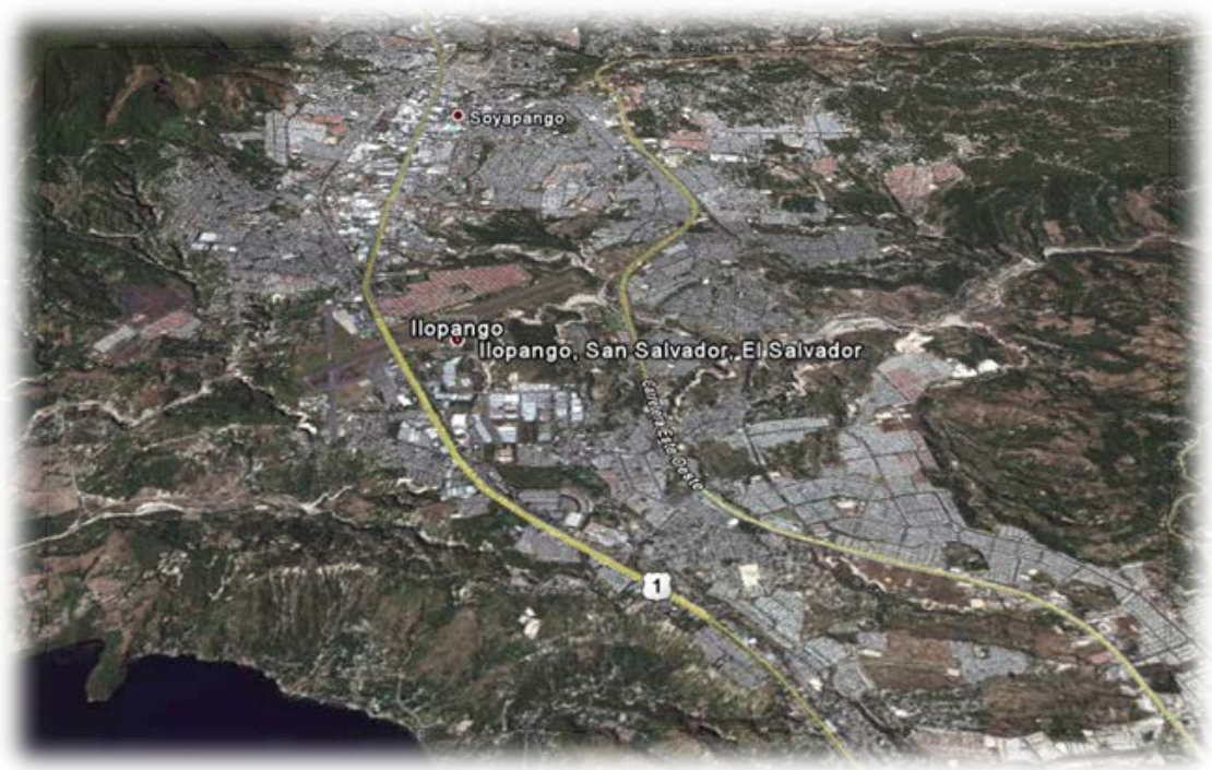
FOTOGRAFÍA N°3.1: Relieve del área en estudio.
