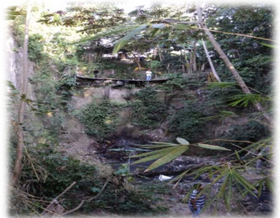
Socavación por caída de agua
