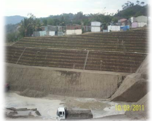
Vegetación en los taludes
