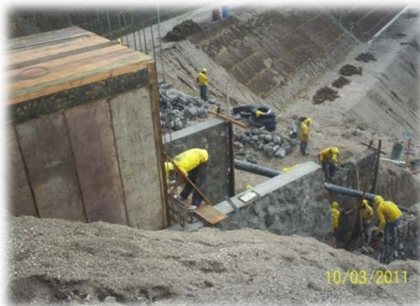
Obras de descarga de aguas lluvias
