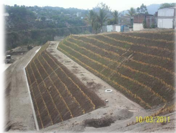
Canaletas en bermas intermedias
