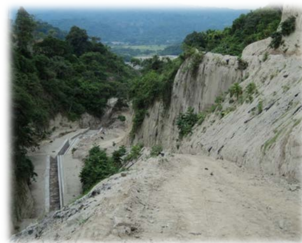
Construcción de obras de remediación en Cárcava
