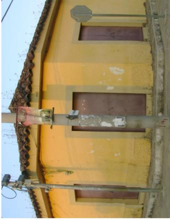
Inmueble de esquina o clave con triple acceso. Cubierta de techo con teja de barro y con tres caídas de aguas.
