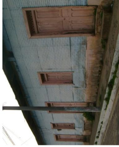
Vanos rectos para puertas y ventanas. Pared de lámina troquelada y estructura de madera.
