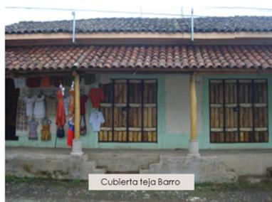
Imagen 103. En Ataco hay diversas materiales utilizados para la cubiertas como teja de barro con estructuras de madera, lámina acanaladas, lámina fibrocemento y láminas troqueladas tipo zinc.
