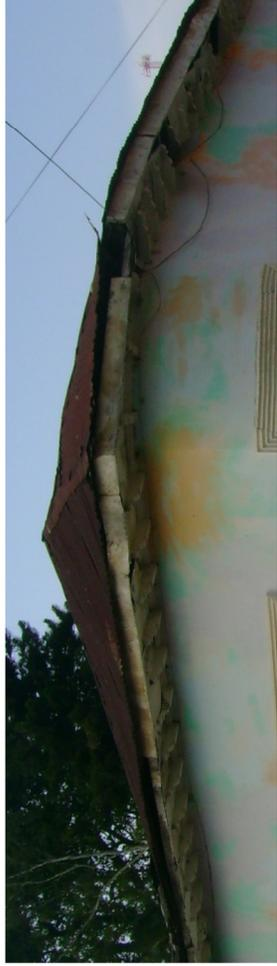
Cubierta de techo con lámina galvanizada con tres caídas de aguas. Remate de fachada con la utilización de cornisa y canchillos de madera.
