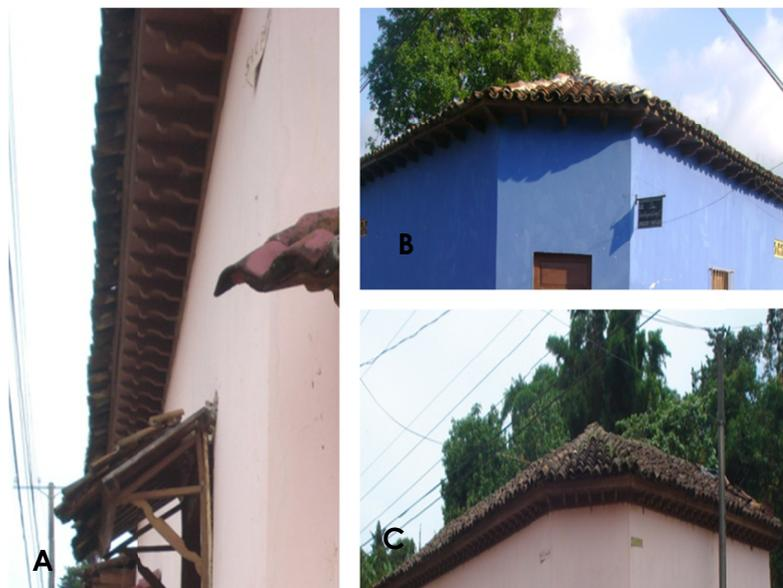
Imagen 105. Aleros que sobresalen de sus tejados (A, B y C), dejando caídas libres de aguas del techo.
