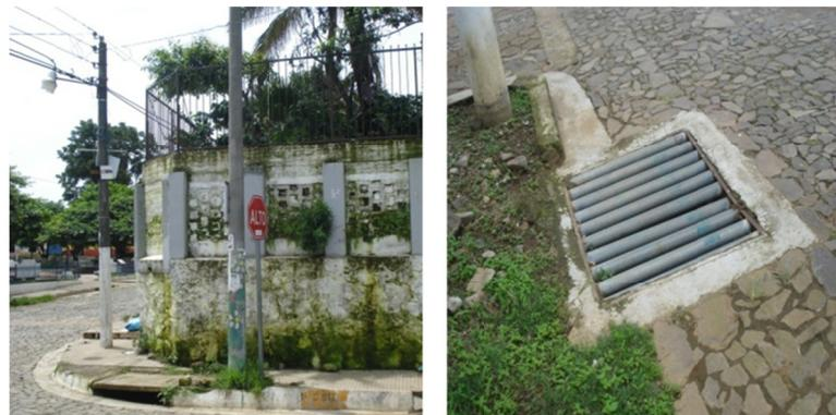
Imagen 55. Infraestructura de la red de aguas lluvias, que están ubicadas en puntos críticos para la recolección de las aguas lluvias, siendo las calles principal vías de drenajes superficiales, debido a que su topografía lo permite, hasta llegar a las cajas tragantes ubicadas en ciertas esquinas.
