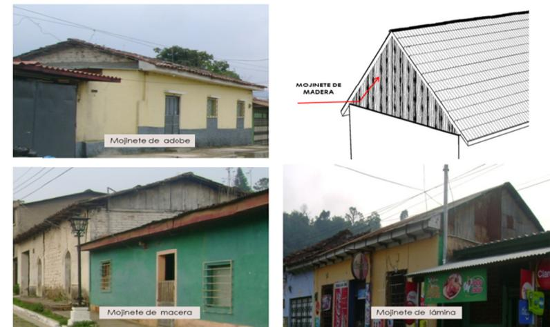
Imagen 102. En las cubiertas podemos observar la diversidad de materiales con lo que han construido los mojinetes en Ataco.
