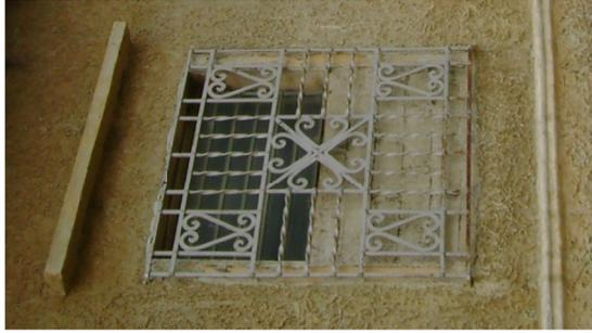
Vano recto de ventana con balcón del tipo dibujo y con moldura en la parte superior.
