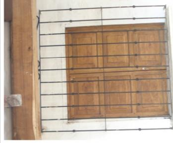
Vano recto para ventanas de madera de doble hoja, con balcones rectilíneos de hierro.
