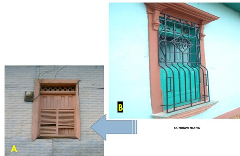
Imagen 116. Estos son ejemplos de Contraventanas que pueden ser de madera (B) y de celosía de madera (A).
