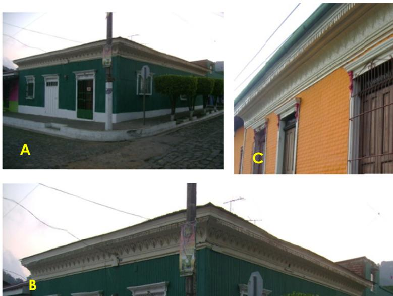
Imagen 107. El uso de cornisa de lámina (A, B y C) sobresale en sus fachadas.
