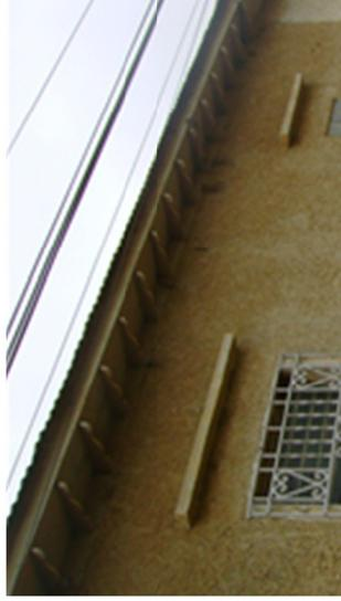
Remate de fachada con alero y canecillos de madera. Moldura sobre huecos de ventanas.
