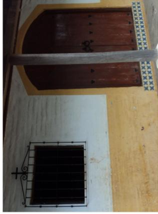
Vano con arco en puerta de madera con doble hoja. Vano recto en ventana de madera con balcón rectilíneo de hierro. Paredes de ladrillo de barro.
