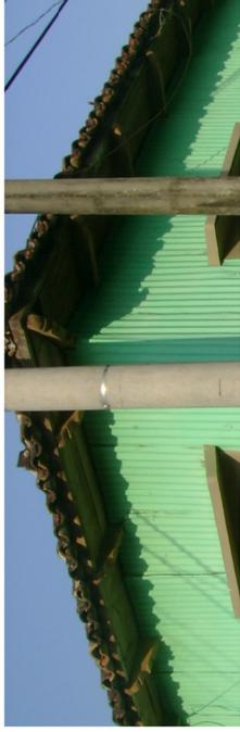
Alero con canchillos de madera y paredes de lámina acanalada.
