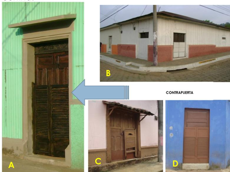
Imagen 113. Estos son ejemplos de contrapuestas que pueden ser de diferentes materiales. Tales como de madera (A, C y D) y lámina de hierro (B).
