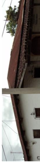
Remate en fachada con alero y canchillos de madera. Cubierta de techos a dos aguas de lámina galvanizada y teja de barro.
