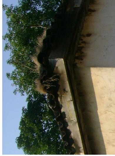
Remate de fachada con cornisa y una cubierta de techo de feja de barro a dos aguas.
