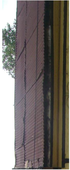
Cubierta del techo con lámina galvanizada. Remate de fachada con la utilización de cornisa.
