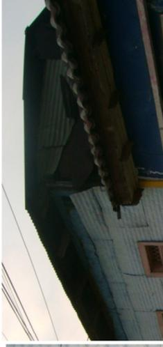
Cubierta de techo a dos aguas de lámina galvanizada y estructura de madera.
