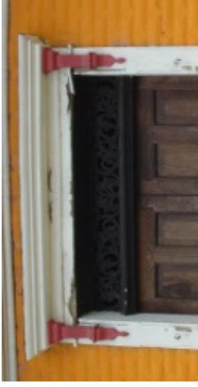
Cornisa de madera y detalle de fimpano calado de madera sobre vano de puerta y ventanas.
