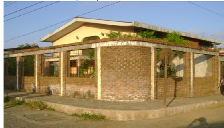
Imagen 126. El sistema constructivo con ladrillo de barro es el que abunda más en las edificaciones.
