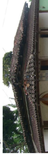
Cubierta de techos a dos aguas de teja de barro, techo de portal a tres aguas con teja de barro.
