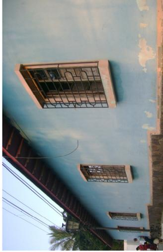
Inmueble de esquina con paredes de ladrillo de barro. Con vanos rectos en ventanas de madera y vidrio, balcones de dibujo.
