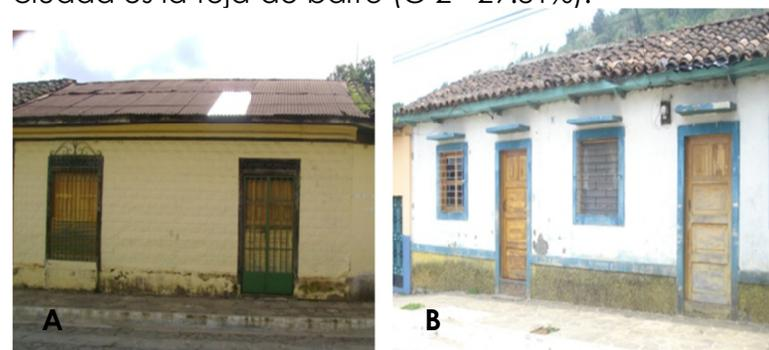
Imagen 104. Cubierta de techo que se observa más es de lámina galvanizada (A) y le sigue la de teja de barro (B).
