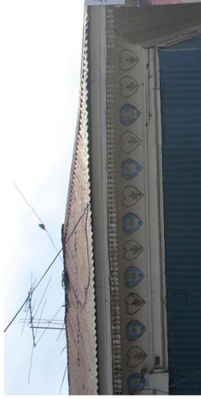
Cubierta de techo con lámina galvanizada. Remate de fachada con cornisa.
