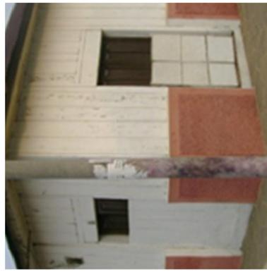
Inmueble de esquina con doble acceso al interior. Posee paredes de madera y ladrillo de barro.
