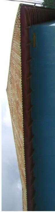
Cubierta de techo con lámina galvanizada. Remate de fachada con aleros y canchillos de madera.
