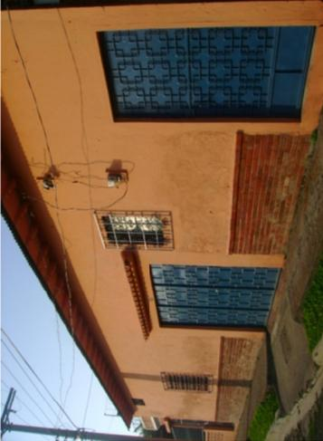
Remates en fachada con alero y canecillos de madera; marquesina en portón y cubierta de techo de lamina a dos aguas.
