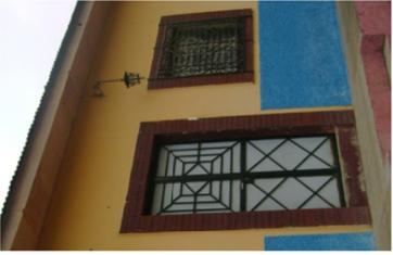
Vanos rectos para puertas y ventanas. Paredes de lamina y de ladrillo de barro.
