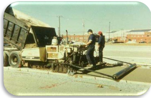
H) Pavimentadora de asfalto
