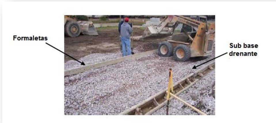
FIGURA 2.32 – Colocación de sub-base y formaletas
