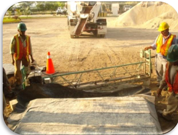
FIGURA 2.37 – Colocación de capa plástica para curado
