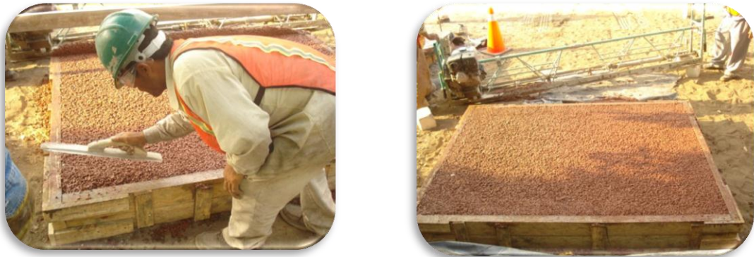
FIGURA 2.35 – Acabado de superficie y textura del pavimento
