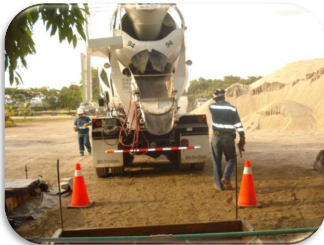
FIGURA 2.33 – Transporte de concreto permeable en camiones premezcladores.
