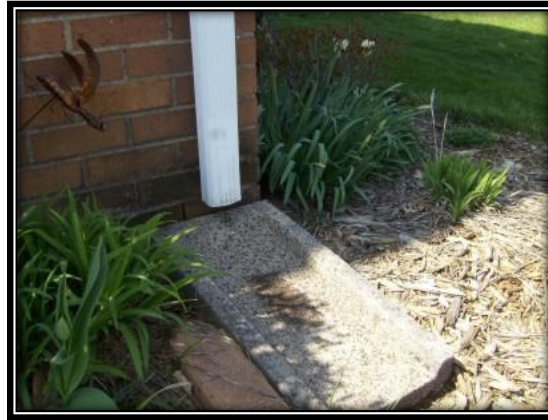
FIGURA 2.4 – Baldosa de drenaje
