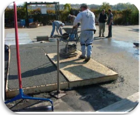
B) Plato Vibrocompactador
