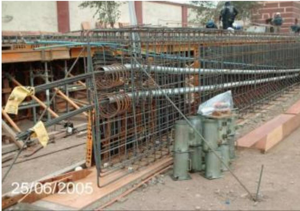
Fig. 2.5 Encofrado primera cara y ductos de presfuerzo
