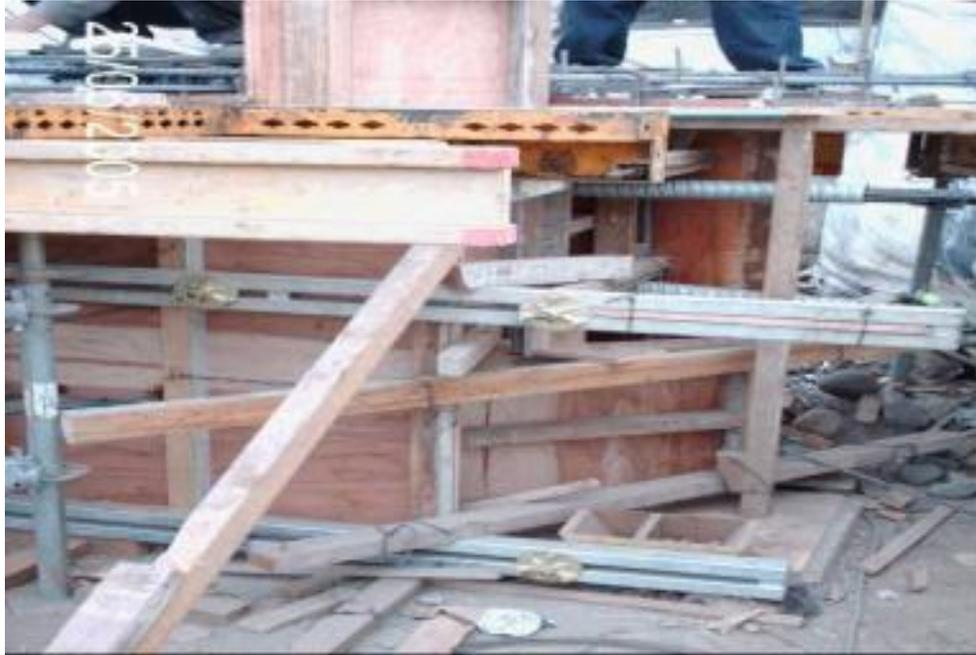
Fig. 2.8 Encofrados en aleros de la viga
