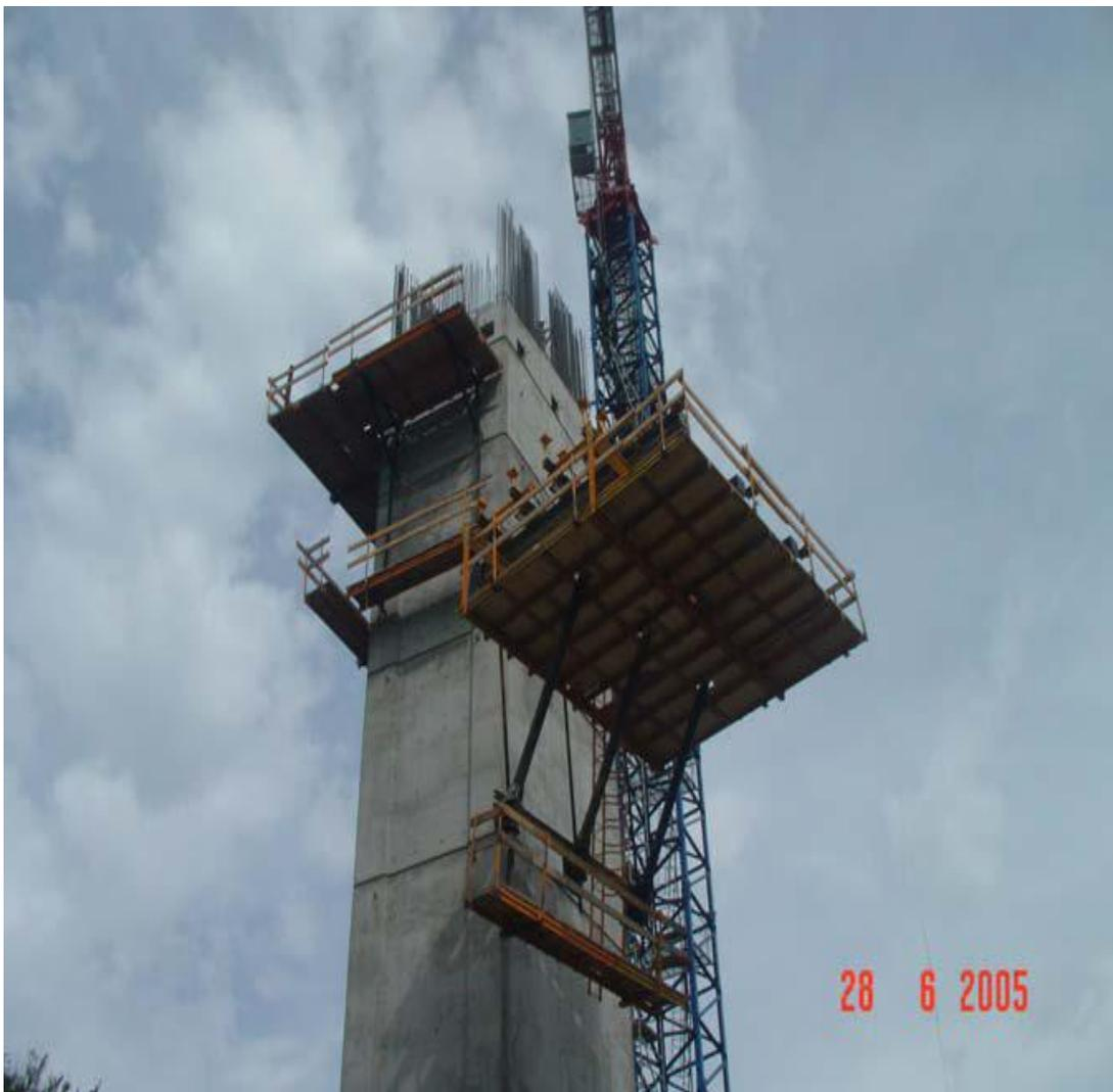
Fig. 3.1 Construcción de pila donde se apoyaran los voladizos
