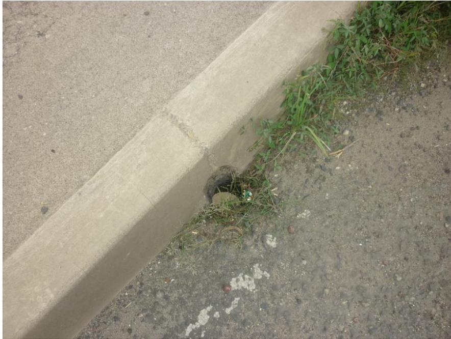
Fig. 4.16 Elemento de drenaje ubicado sobre la longitud del puente Colima con presencia de acumulación de maleza
