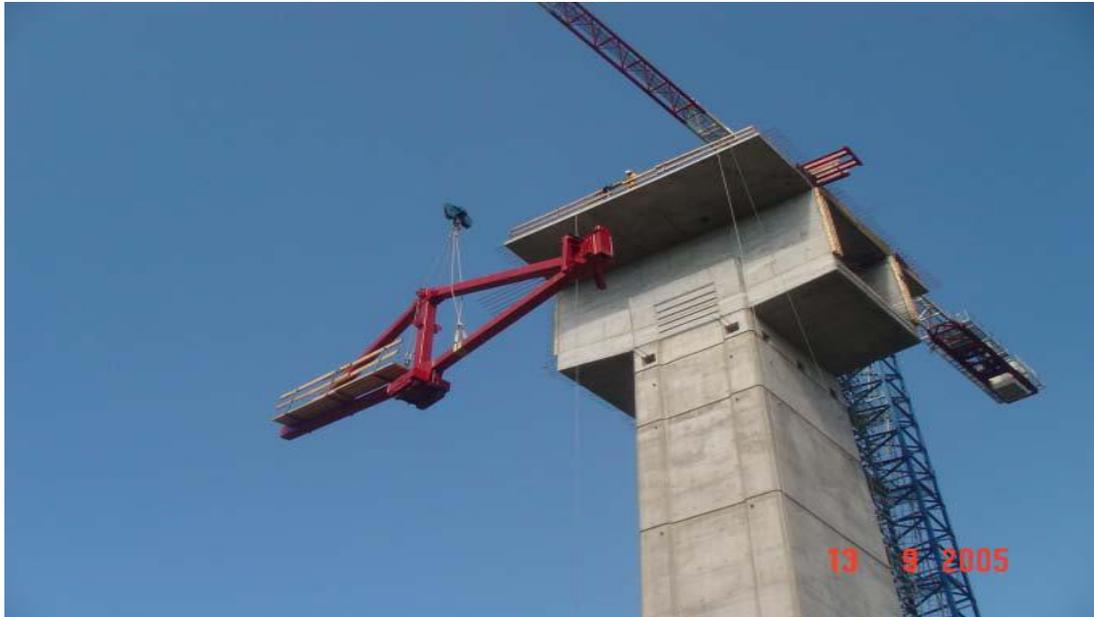
Fig. 3.7 Izado de la estructura en rombo del carro de avance
