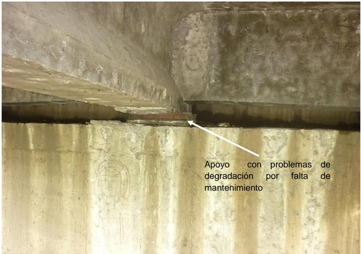
Fig. 4.15 condición actual del apoyo en zona de estribo acceso norte
