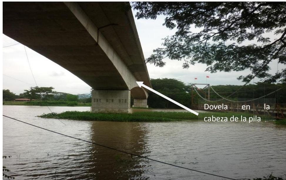
Fig. 4.11 Representación de las dovelas del puente Colima
