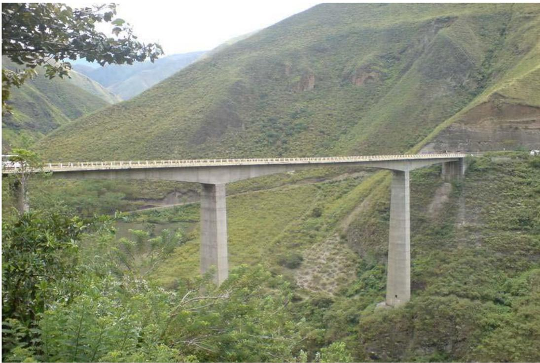
Fig. 3.14 Construcción completa con método de doble voladizo
