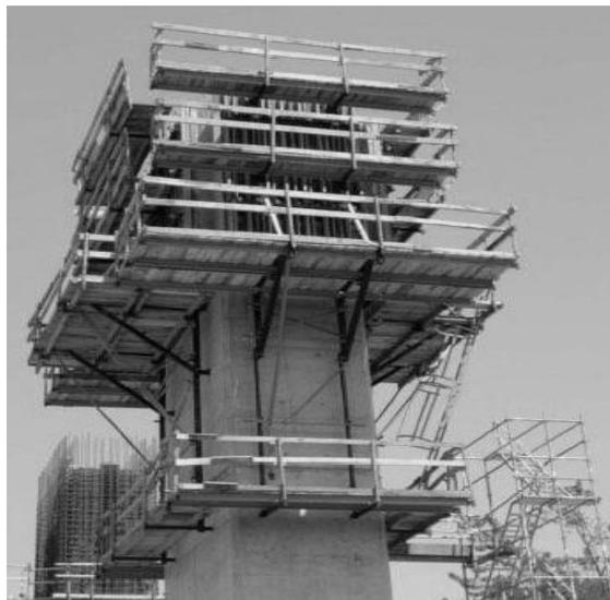
Fig. 2.22 Proceso constructivo de pila utilizando encofrado deslizante
