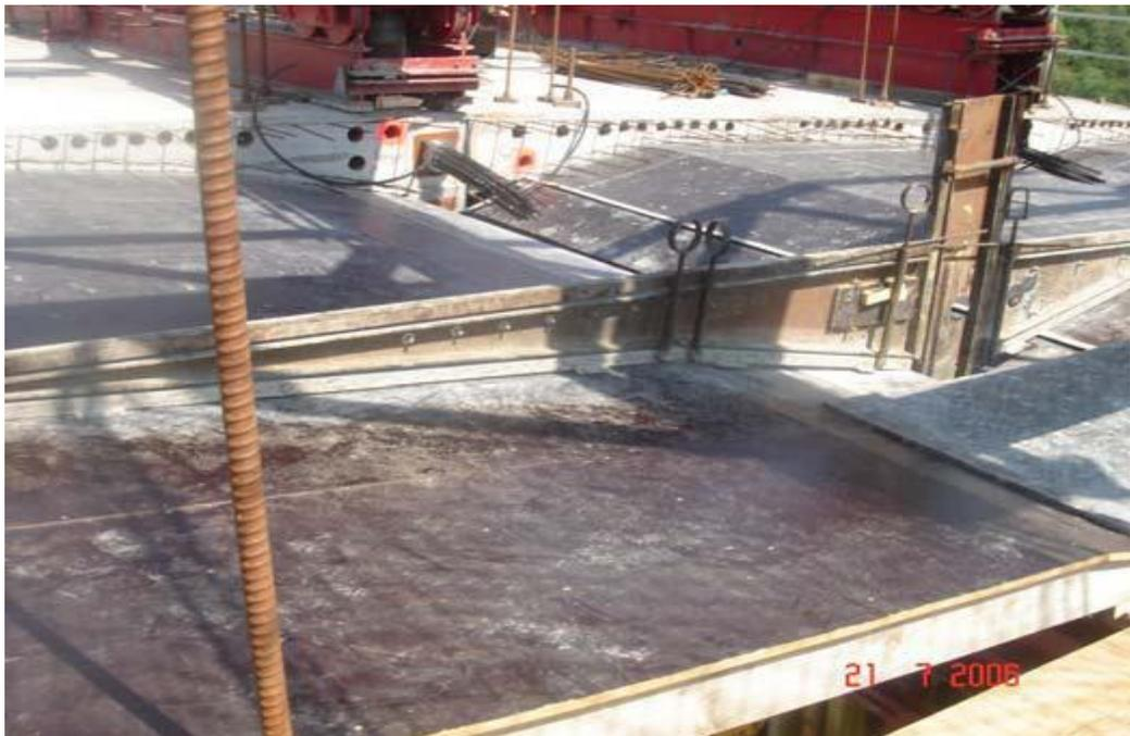
Fig. 3.10 Preparación de los encofrados para ejecutar la dovela
