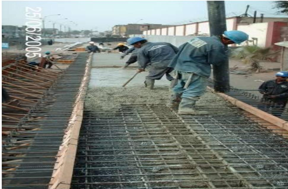
Fig. 2.12 Vaciado y vibración del Concreto
