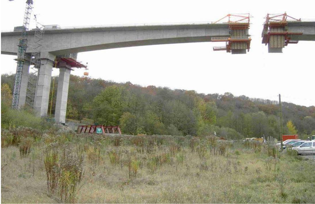
Fig. 3.13 Vista de dovelas llegando a etapa de la dovela de cierre
