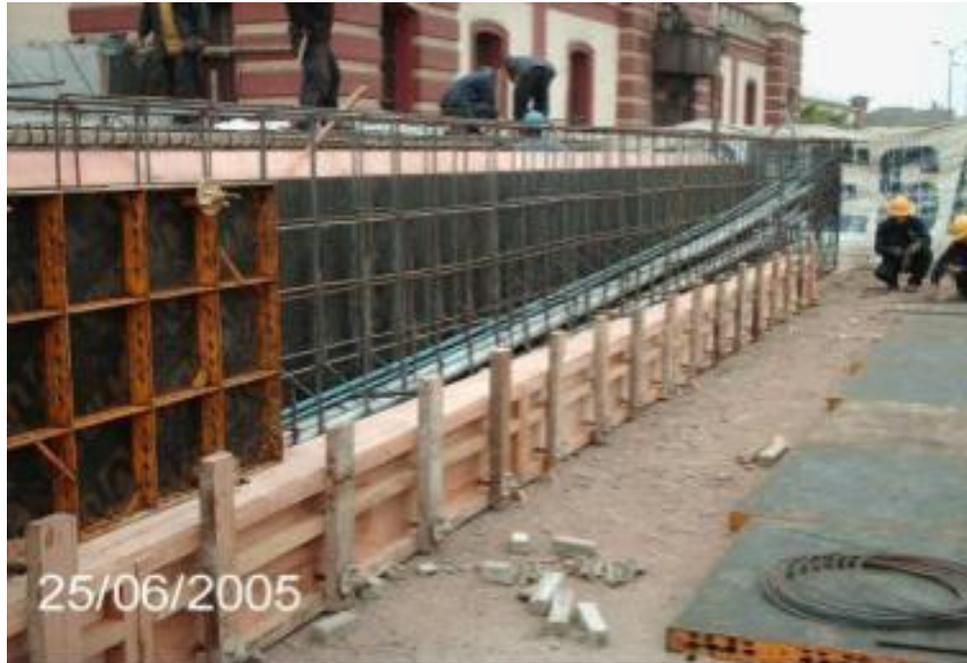
Fig. 2.6 Colocación de encofrado segunda cara
