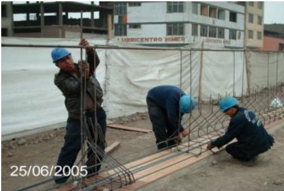
Fig. 2.3 Colocación de acero de refuerzo
