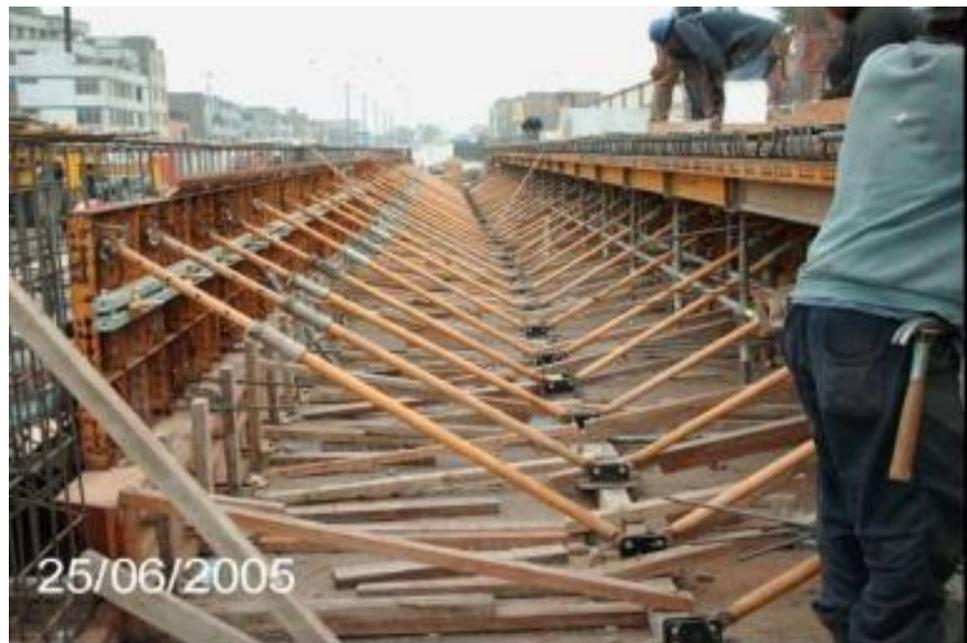
Fig. 2.7 Apuntalamiento del encofrado
