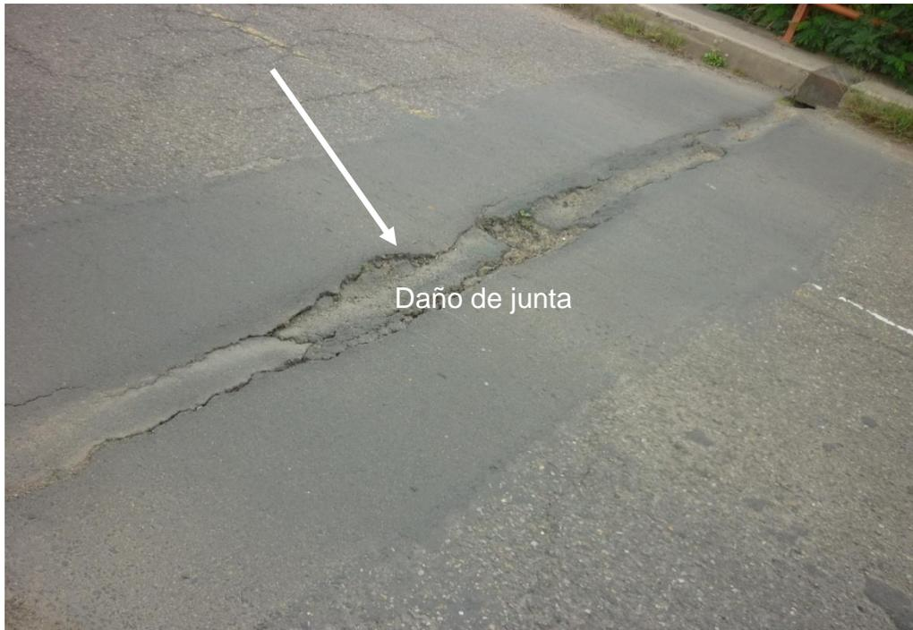
Fig. 4.13 Condición actual de las juntas del puente Colima
