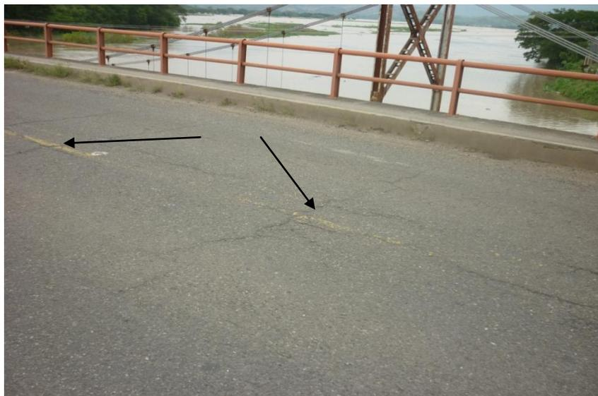
Fig. 4.4 Fisuras manifestadas en la carpeta de rodadura
