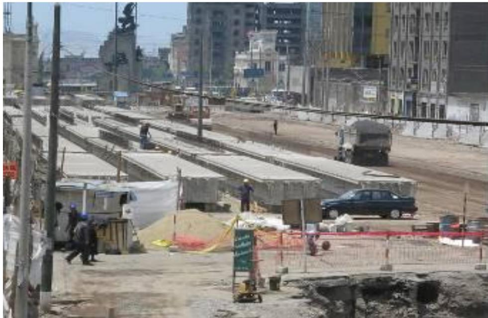
Fig. 2.13 Vigas pretensadas almacenadas
