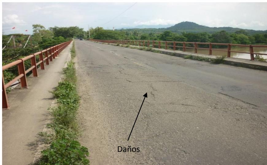
Fig. 4.12 Daños en la carpeta de rodadura
