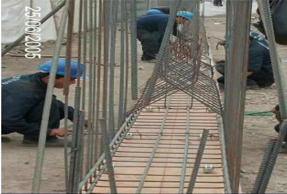
Fig. 2.4 Colocación de acero de refuerzo
