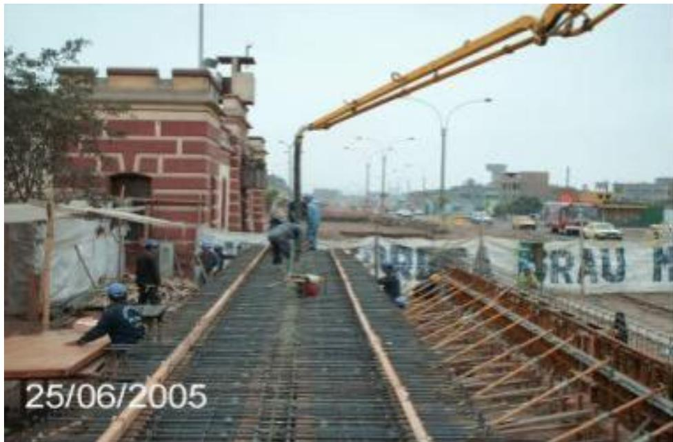
Fig. 2.11 Vaciado del concreto
