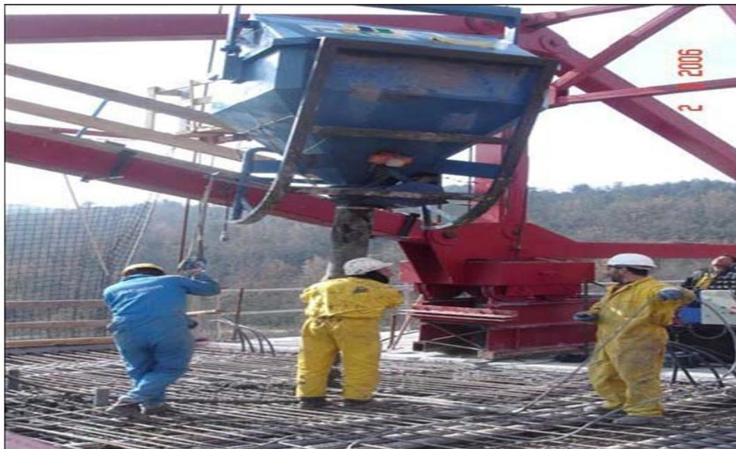
Fig. 3.12 Hormigoneado de la dovela
