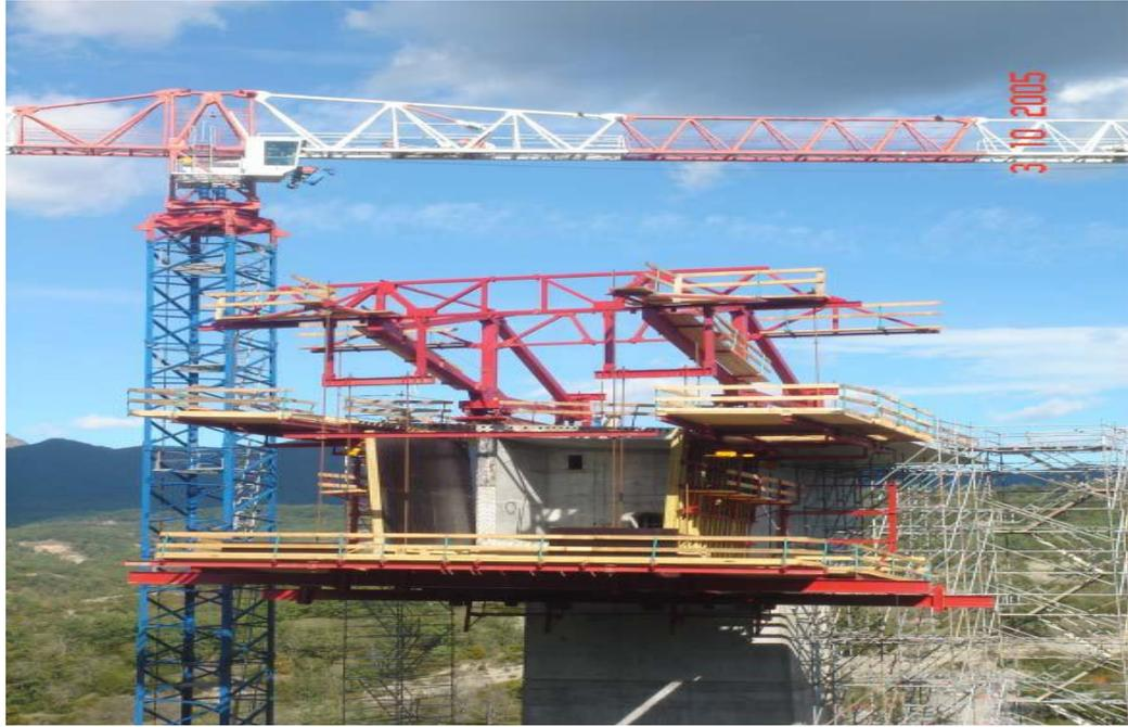
Fig. 3.9 Montaje de los encofrados laterales del carro de avance
