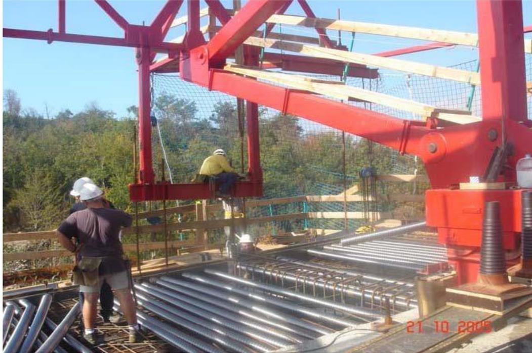
Fig. 3.11 Colocación de las vainas de pretensado
