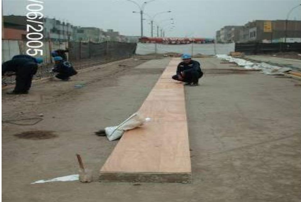
Fig. 2.2 Encofrado de fondo de viga
