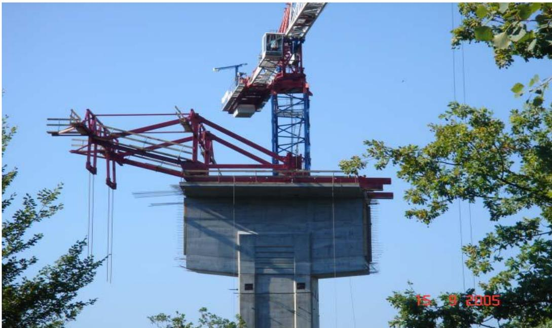
Fig. 3.8 Carro de avance con los carriles, estructuras en rombo, vigas celosía y arriostramientos horizontales montados
