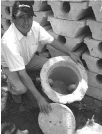
Figura. 7.7.4. Retiro de la trampa de grasas de la cocina para la limpieza.
