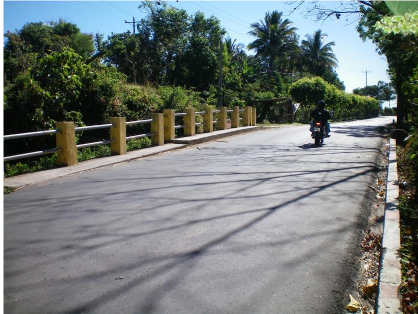
Fotografía 7.9.20: Bóveda sobre Río Istepeque.
