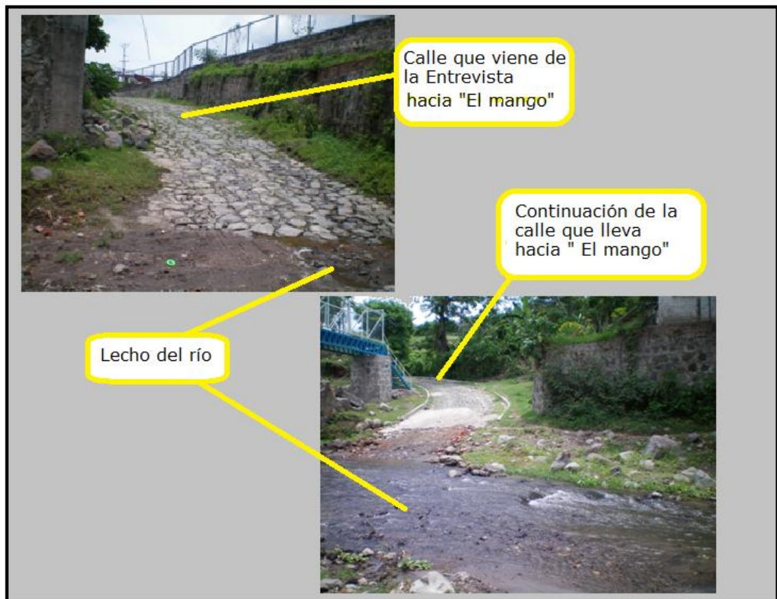
Figura 4.5.1. Fotografías que ilustran el nivel al que llegan las calles al río Acahuapa. Fuente: Elaborado por equipo de Trabajo de Graduación.
