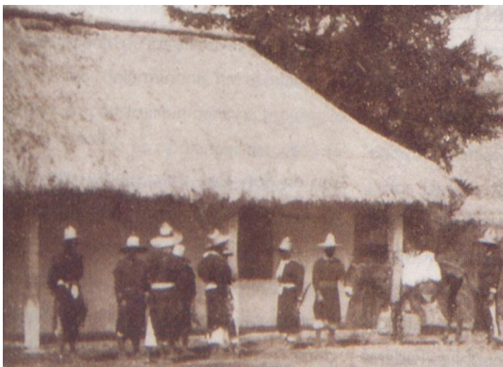
Imagen No. 4 Viviendas de Adobe y tejado de Paja. Fuente: Historia del Istmo Centroamericano, tomo 2.
