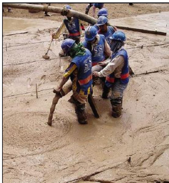
Figura 2.8.5 Colocación de MBRC por bombeo a través de tubería. 29
