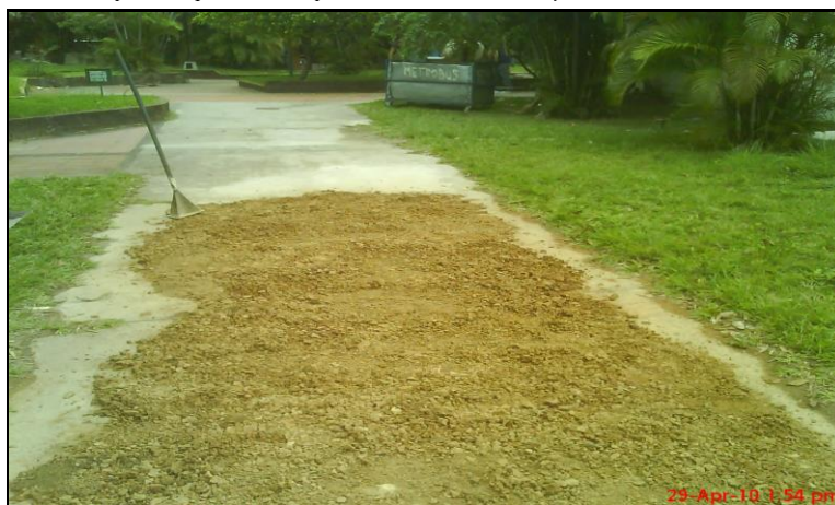
Figura 5.1.1 Muestra la preparación del material, el cual es tendido, exponiéndolo al sol para que este pierda humedad y desmenuzarse.
