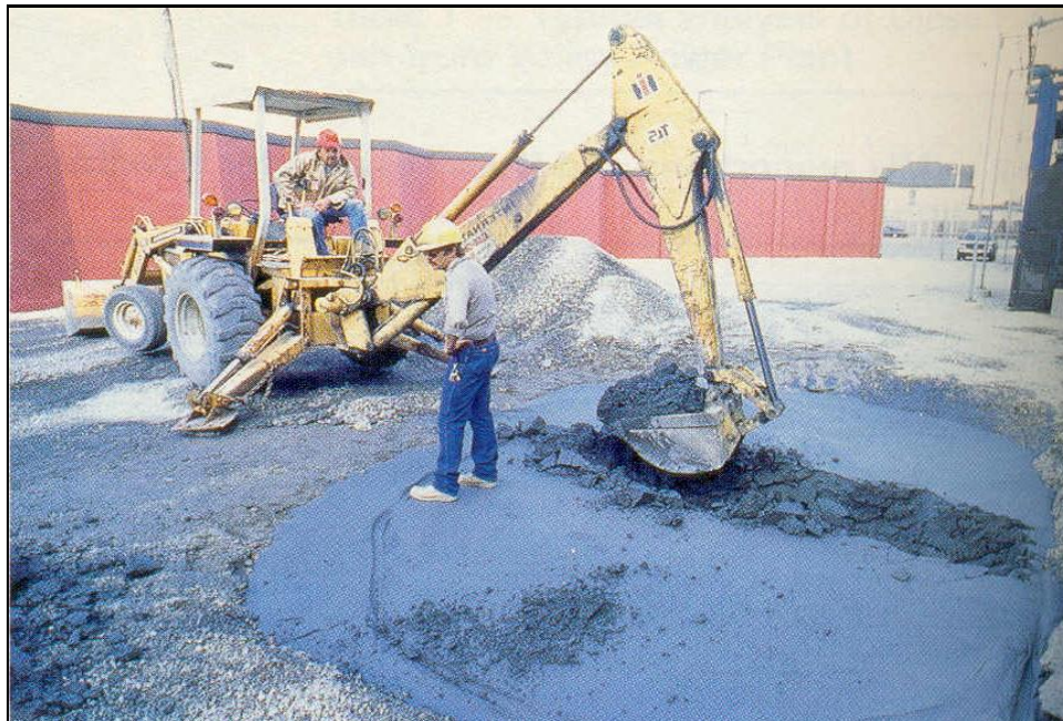
Figura 2.6.1: Muestra el proceso de excavación de un relleno con MBRC, utilizando una retroexcavadora. 23
