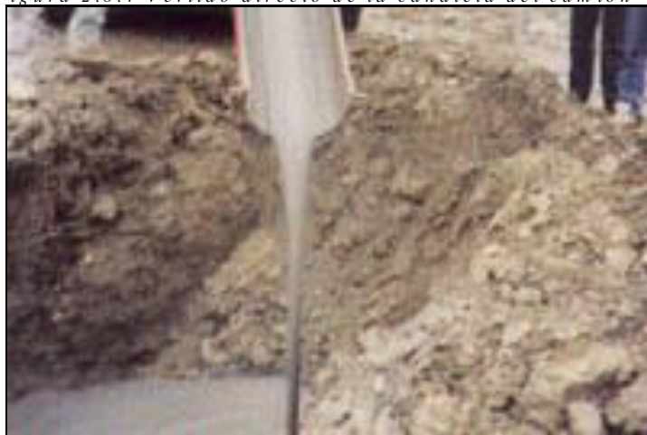
Figura 2.8.4 Vertido directo de la canaleta del camión 28 .
