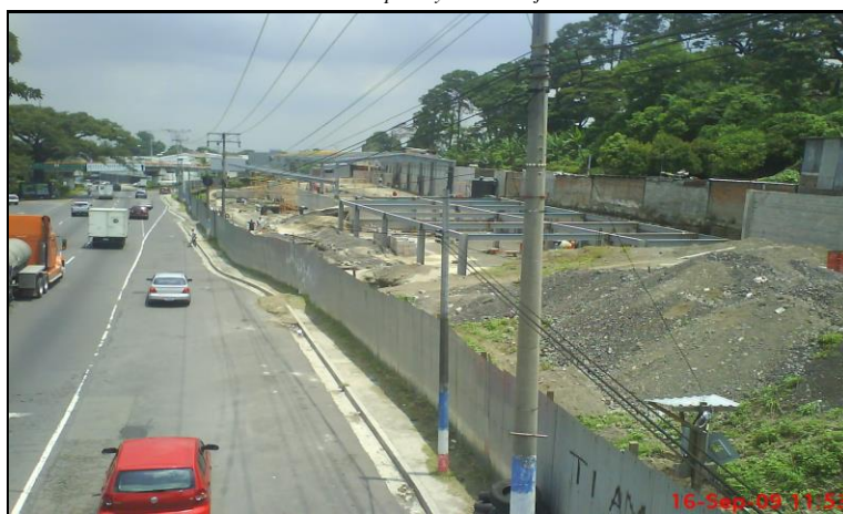
Figura 3.2.2 Muestra accesibilidad al banco de material, así como material extraído producto de excavaciones del proyecto ejecutado en el banco N°1
