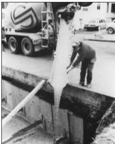
Figura. 2.8.3 Colocación del relleno fluido en una cavidad 27 .
