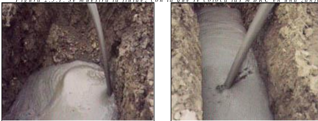
Figura 2.5.1. Se muestra la fluidez con la que se coloca las MBRC en una zanja.
