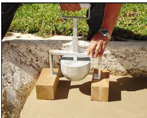
Figura 2.9.12. Colocación del aparato de caída de bola 46
