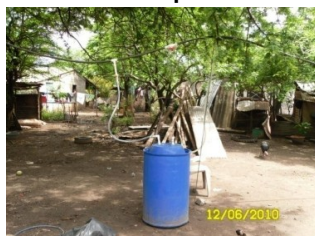
Biodigestor San marcos lempa.
