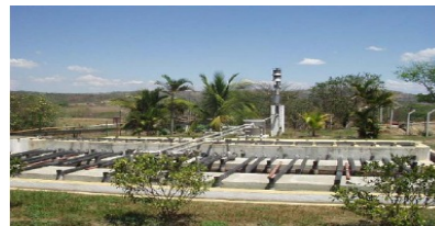
Biodigestor de Cafeco. Quezaltepeque.
