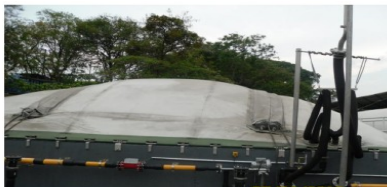
Biodigestor de La Constancia.
