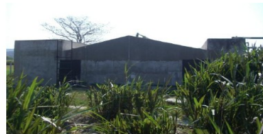
Biodigestor Planta Miralvalle. Santa Ana.
