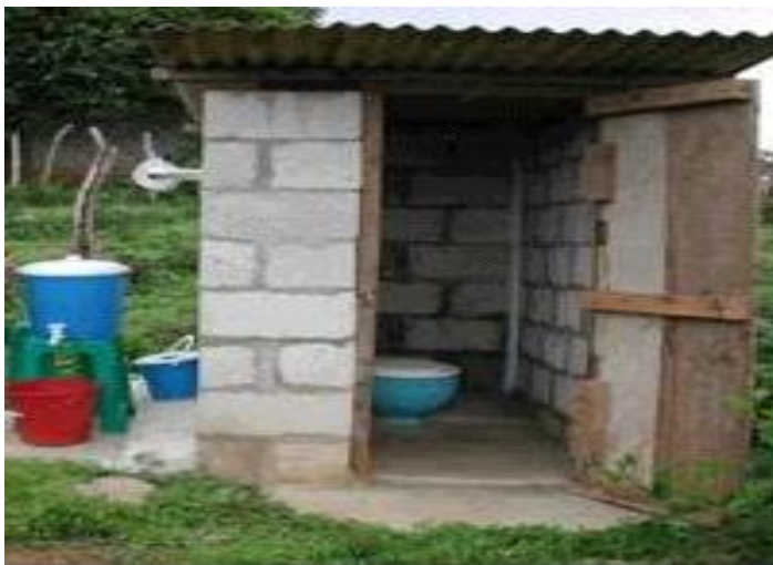
Fig. 3 Instalación sanitaria en la parcela
