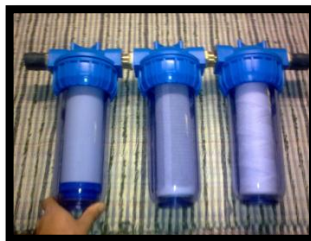
Ilustración 68: Filtros de sedimentos
