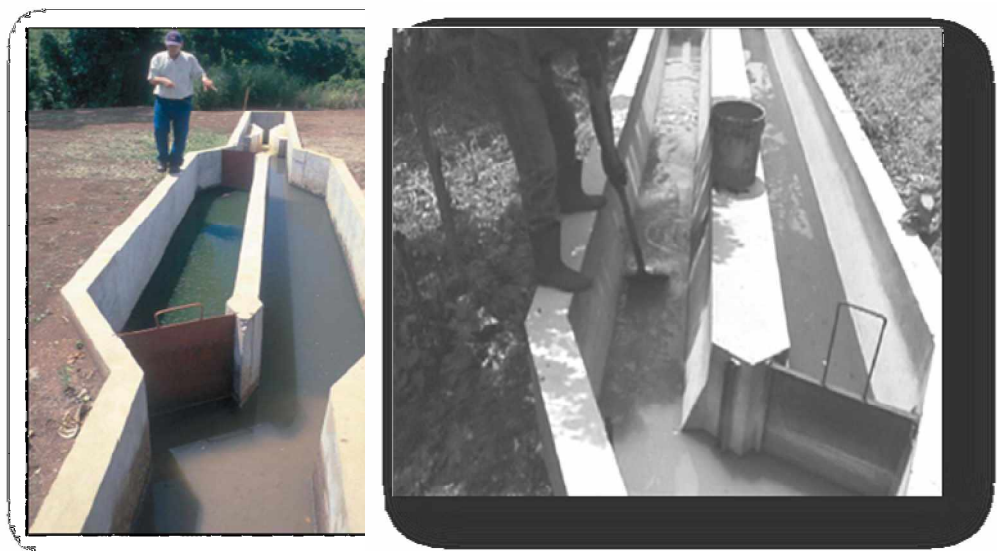
FIG 9.3 Limpieza de desarenador
