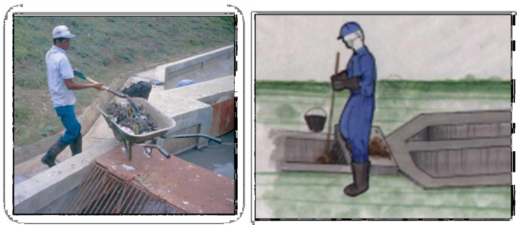
FIG 9.1 Limpieza de rejillas
