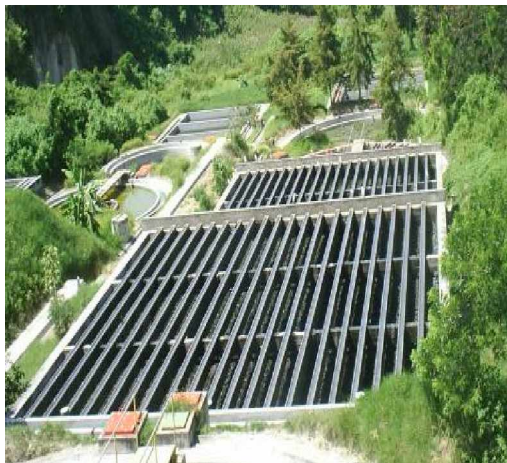
FIG 2.15 Vista de la parte superior de un filtro percolador
