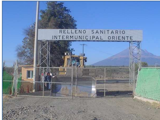
Imagen 5.8 Portón y caseta de control de un relleno sanitario
