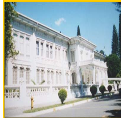
Ex Cuartel El Zapote y Edificio de La Ex Casa Presidencial
