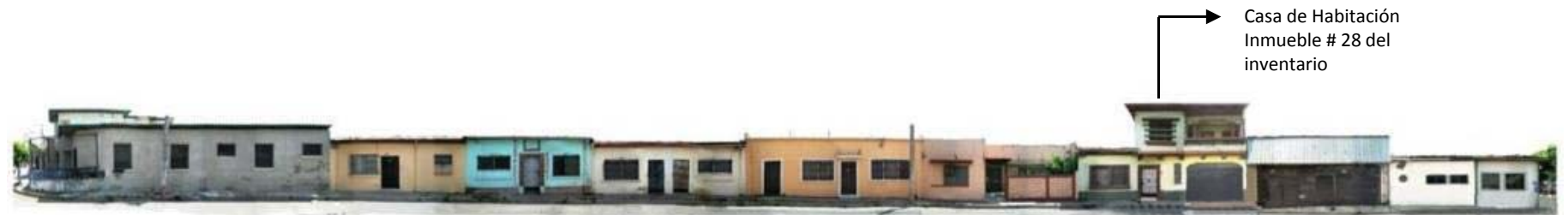
Fotografía 2-38: Pasaje Constructora, norte
