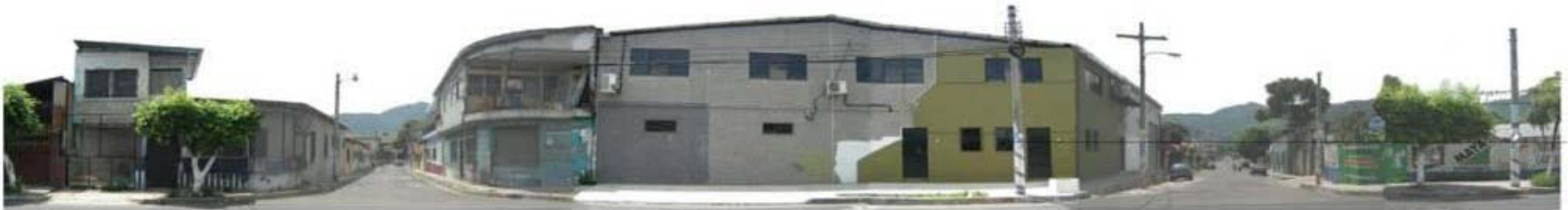
Fotografía 2-28: 10° Sur Oriente, Pasaje Constructora y Calle Darío González
