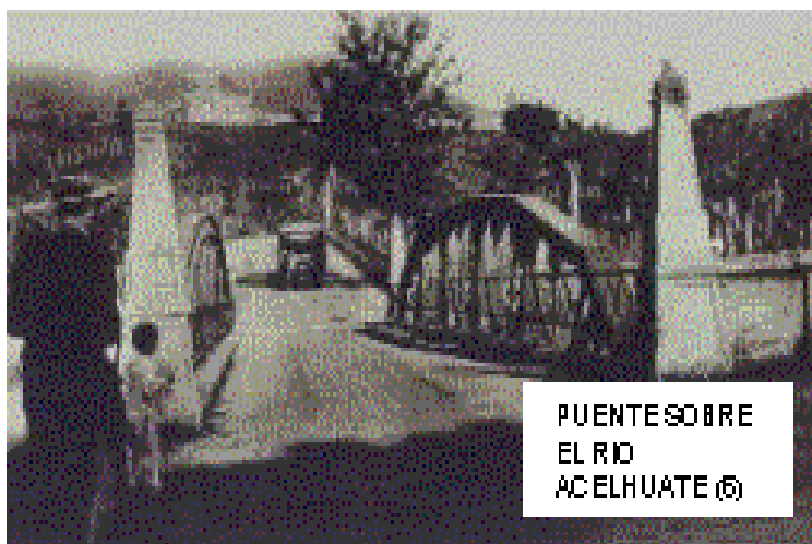
Fotografía 2-2 Puente sobre Río Acelhuate
