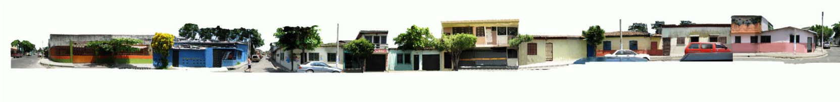
Fotografía 2-50: PERFIL EXISTENTE AVENIDA IRINEO CHACÓN COSTADO PONIENTE, tramos sur y central
