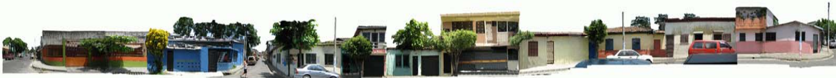
Fotografía 2-33: Avenida Irineo Chacon, Poniente
