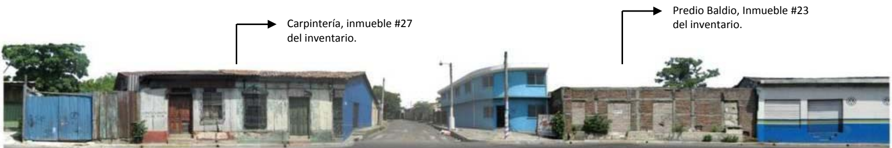
Fotografía 2-30: Calle Lindo y 10° Av. Sur, Poniente
