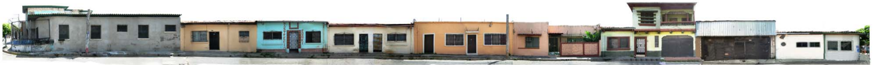
Fotografía 2-1 PERFIL EXISTENTE PASAJE CONSTRUCTORA COSTADO NORTE
