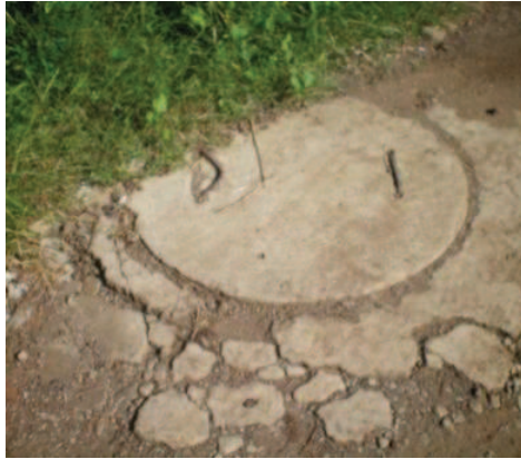
(Fig. 10). Pozo de aguas negras.
