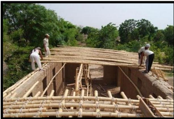
Imagen 7: Colocación de una estructura de techo de bambú a una vivienda de Adobe
