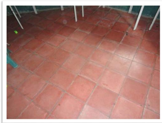
Foto 33: CDIC Piedras Pachas, vista de piso
