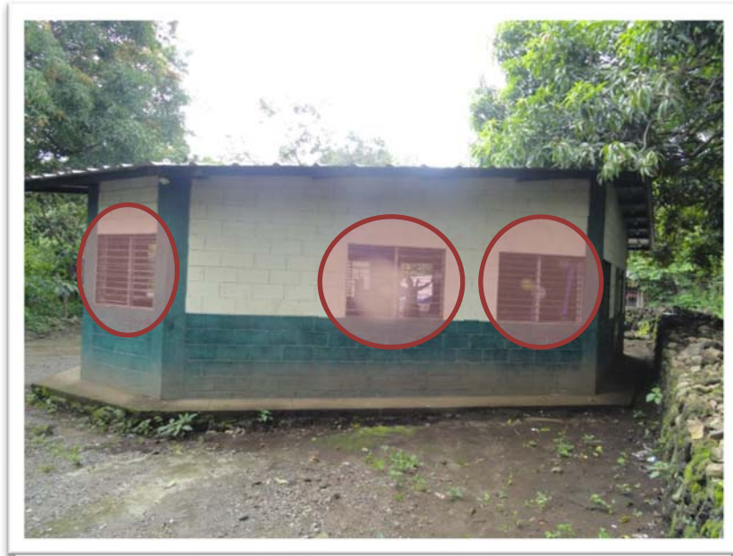
Foto 35: CDIC Piedras Pachas, vista Exterior
