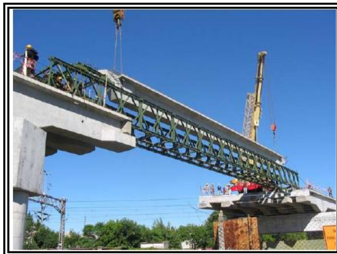
FIG. 2. 150 Montaje de vigaprefabricada viga de lanzamiento.
