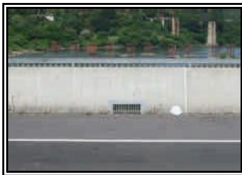
(c) Drenaje situado a un costado del barandal de concreto, con pasamanos metálicos - (Drenaje de rejillas).
