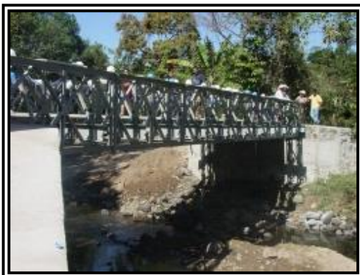
FIG. 2. 40 Puente tipo Bailey “El Carrizo”, entre los cantones Oratorio y San José, en Hobasco, El Salvador. 66
