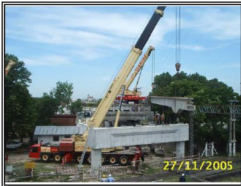
FIG . 2 . 148 M ontaje de vigas prefabricadas .
