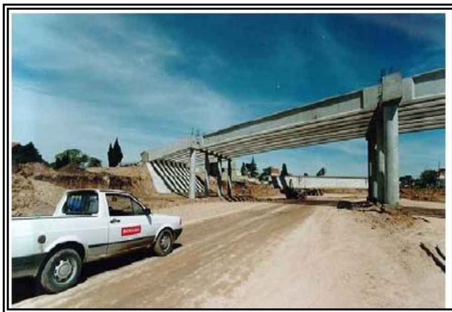
FIG. 2. 147 Puente con vigas premoldeadas.
