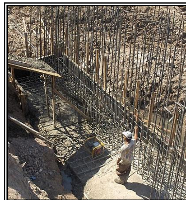
FIG. 2. 143 Armadura de pila tipo pared.
