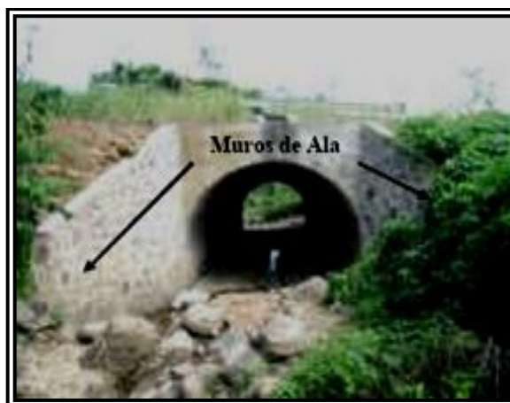
FIG. 2. 67 Componentes de un estribo.
