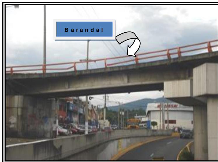
FIG. 2. 138 Ejemplo de baranda de un puente 164 .
