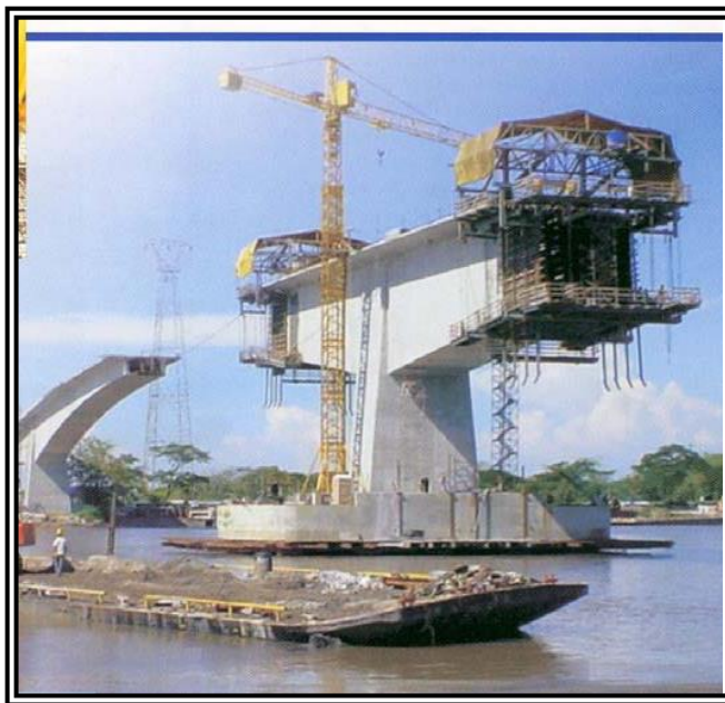
FIG. 2. 154 Avance de los carros en forma simétrica hacia el centro del claro.
