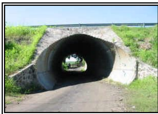
FIG. 2. 41 Puente tipo Super Span 67 .
