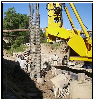
FIG. 2. 142 Armadura de pilote.
