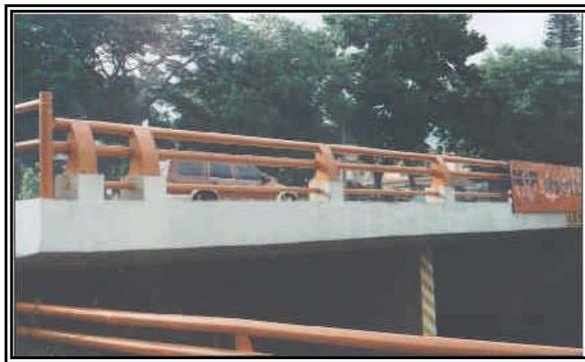
(c) Barandal metálico con bordillos de concreto reforzado (Barandal tipo ASSHTO)
