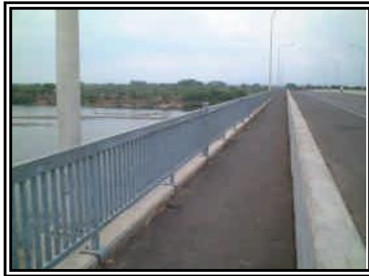
(b) Barandales y pasamanos metálicos
