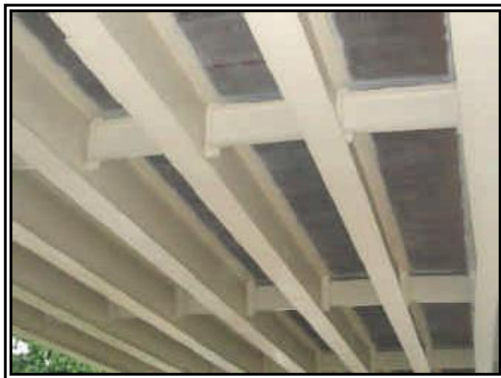
FIG. 2. 42 Diafragmas transversales en vigas de acero. 68
