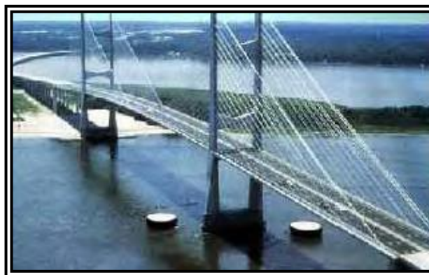
FIG . 2. 13 Puente atirantado con doble plano de atirantamiento 42
