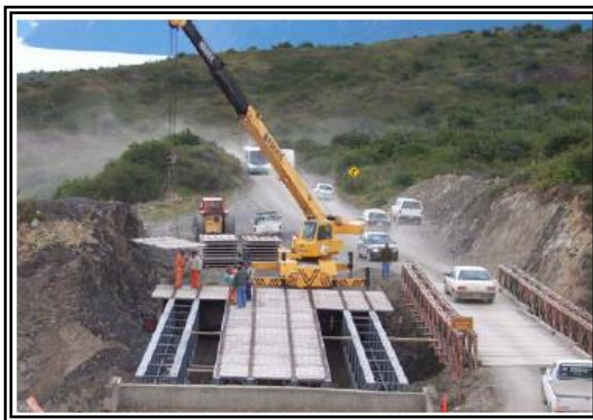
FIG . 2 . 149 M ontaje de losas prefabricadas .
