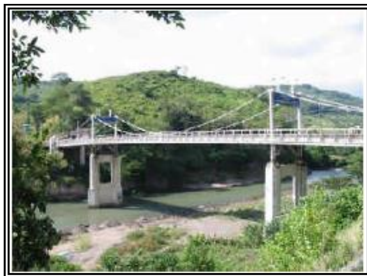
FIG . 2. 11 Puente Colgante “El Jobo” sobre el río paz, ubicado entre Ahuachapán – Frontera Las Chinamas; departamento de Ahuachapán, El Salvador. 41
