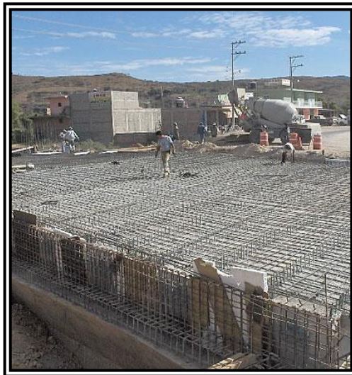
FIG. 2. 146 Refuerzo del acero para losa de un puente colada in situ.
