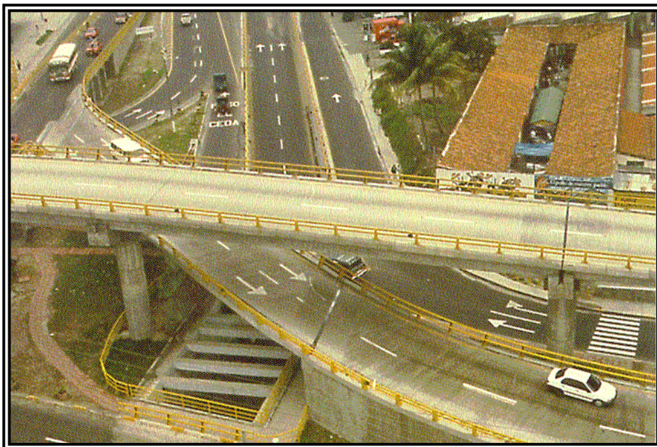
FIG. 2. 8 Paso a desnivel de vigas de concreto preesforzado, Hermano Lejano, El Salvador. 38
