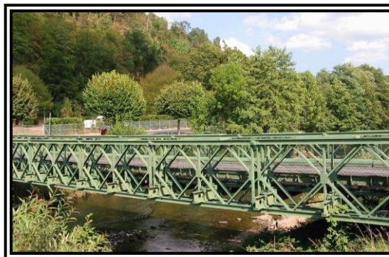
FIG. 2. 27 Puente tipo Bailey. 51
