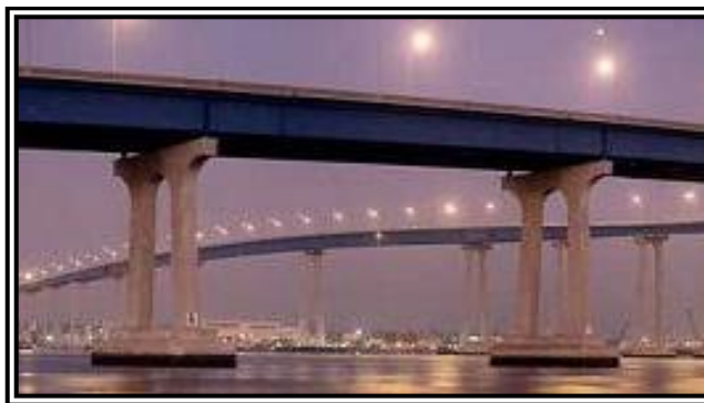
FIG. 3.50 Soportes intermedios o pilas de un puente.
