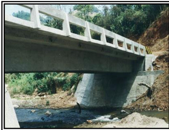
FIG. 2. 5 Puente con vigas longitudinales de concreto reforzado 34 .
