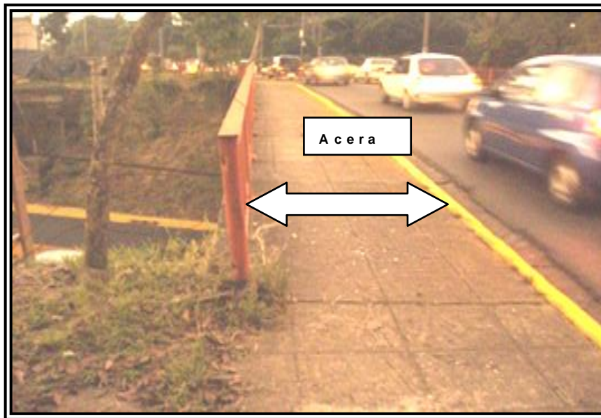
FIG. 2.135 Ejemplo de acera de un puente 161 .
