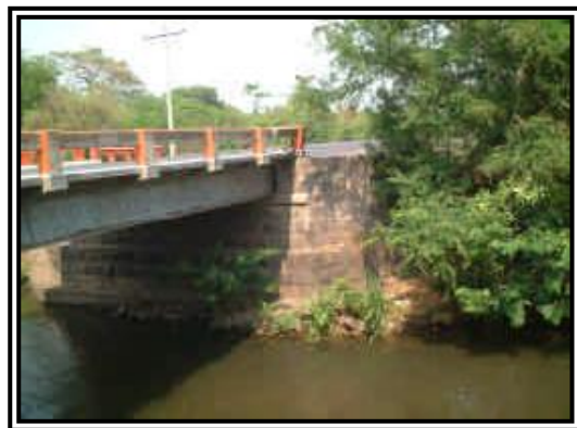
(a) Barandales y pasamanos de concreto
