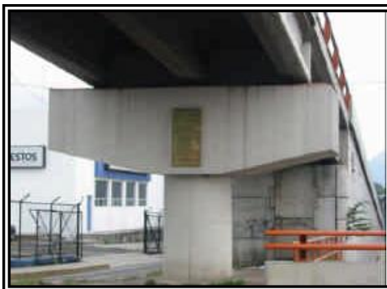
FIG. 2. 77 Pila tipo cabeza de martillo, sobre Paso 3° nivel Blvd. Venezuela (Int. 49° A v. Sur), El Salvador.
