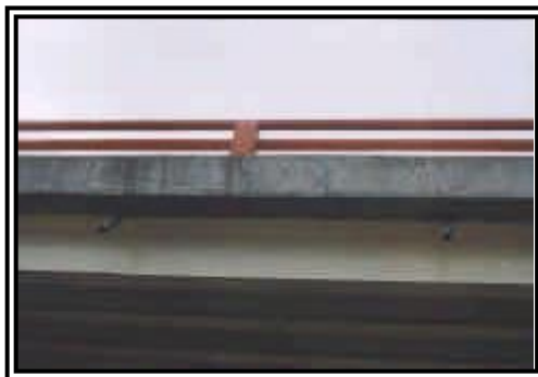
(a) Drenaje situado a un costado de la losa - (Drenaje de acero).
