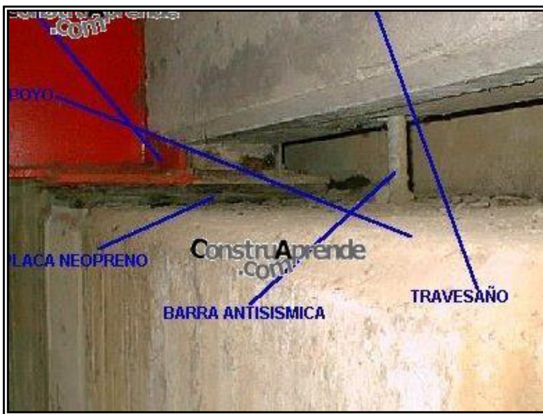
FIG. 2.66 Estribo con barra antisísmica
