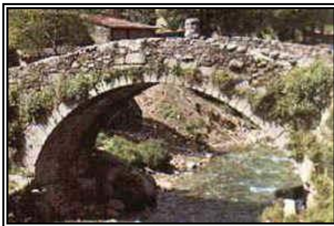
FIG. 2.3 Puente de mampostería de piedra en forma de arco 25 .
