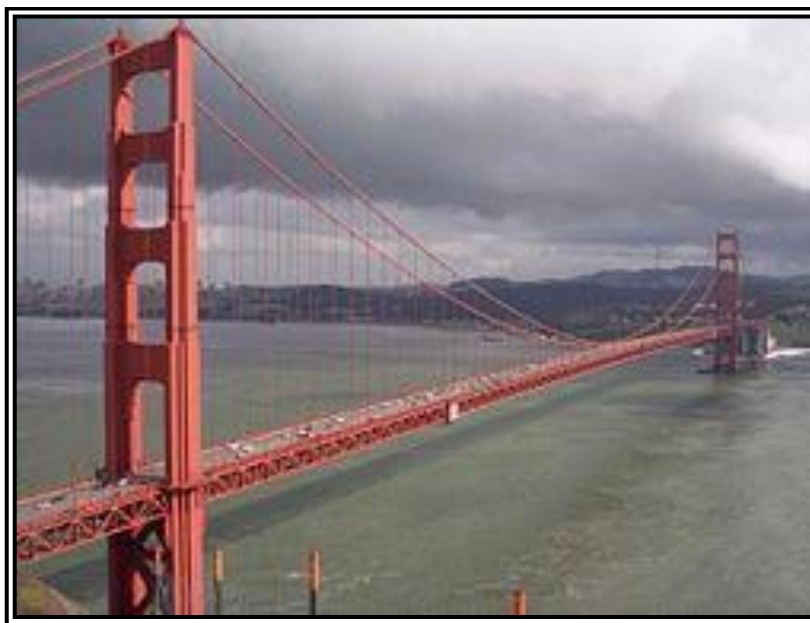
FIG. 2. 12 Golden Gate Bridge, uno de los más famosos, y récord de longitud del vano central durante muchos años. San Francisco (California), EE.UU.
