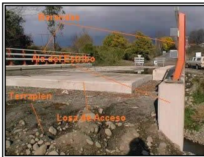
FIG . 2. 110 A las del Estribo
