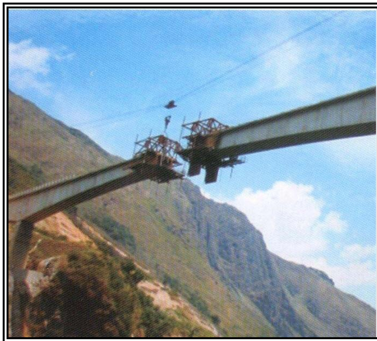
FIG. 2. 155 Sistema de voladizos sucesivos.
