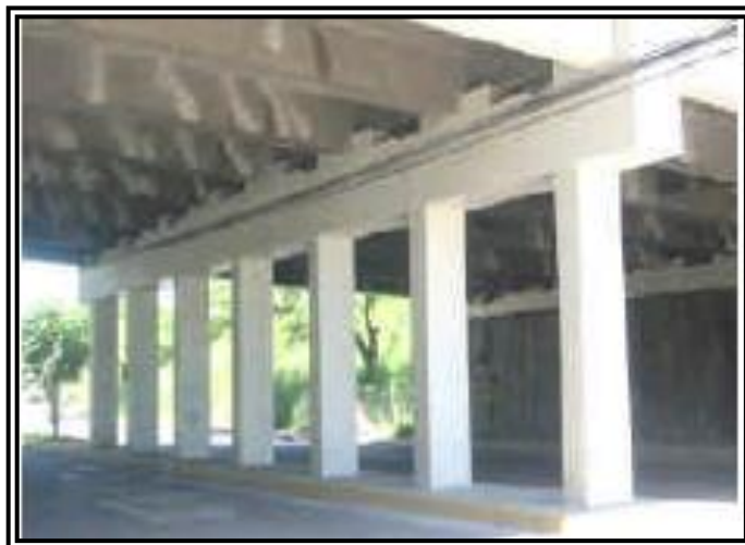
FIG. 2. 73 Pila tipo marco, ubicada en el Blvd. Tutunichapa (Sobre Prol. Universitaria), El Salvador. 90
