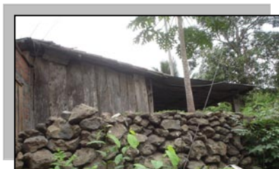
Imagen No. 8 Material Pétreo, muy utilizado en el Cantón para la elaboración de muros y cimientos.
