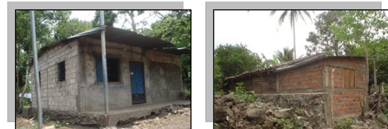
Imagen No. 4 y 5 Vivienda de ladrillo de barro y bloque de concreto
