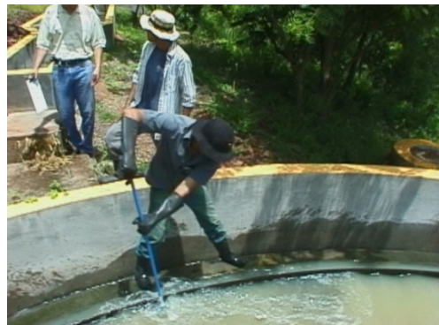
Figura 7.5 Limpieza de canal perimetral
