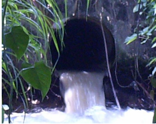
Figura 3.3 Tubería de descarga de alcantarillado existente
