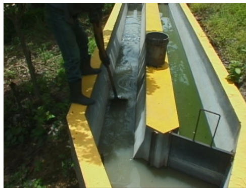
Figura 7.2 Limpieza manual de desarenador
