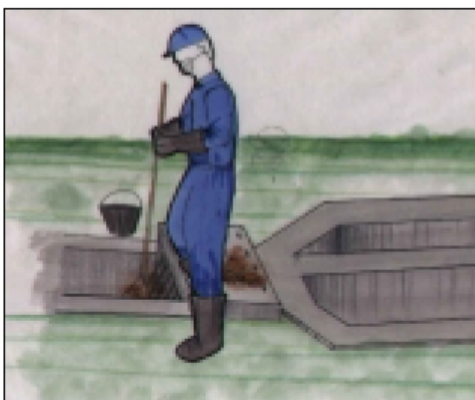
Figura 7.1 Limpieza de rejillas
