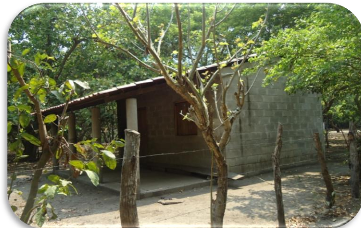
Fotografía 16. Vivienda construida con bloque de concreto y lamina galvanizada en la cubierta. La mayoría de las viviendas poseen esta tipología de vivienda.
