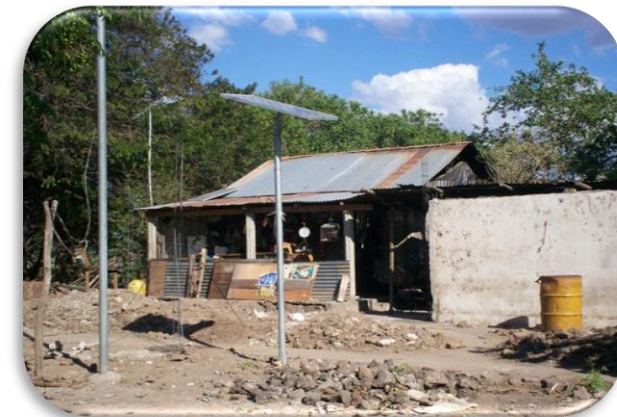
Fotografía 43. Caserío La Barra, Metapan.
