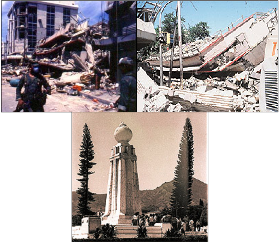
FIGURA 2.15. Imágenes del colapso del Edificio Rubén Darío y el Monumento al Salvador del Mundo. (Fuente www.elsalvador.com )
