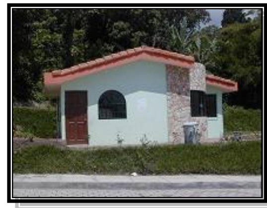
Fotografía No 62 Área Administrativa Existente
