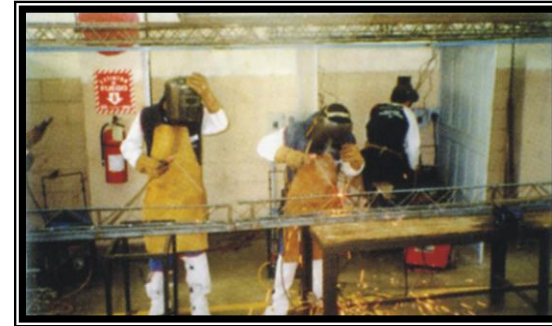
Fotografía No 16 Taller de soldadura
