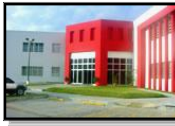
Fotografía No 8 Fachada principal De FEPADE
