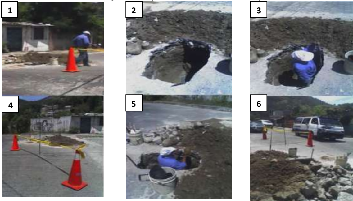
Imagen No. 8: Reparación de Tubería en Calle Principal
